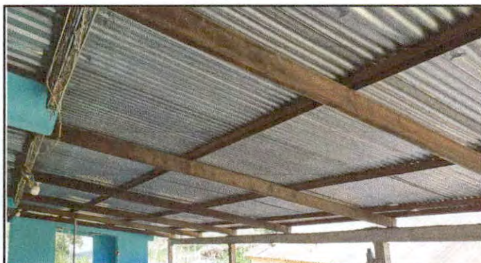
Foto 3: Mantenimiento de las costaneras de metal, techo del patio del edificio escolar, Módulo 1.
