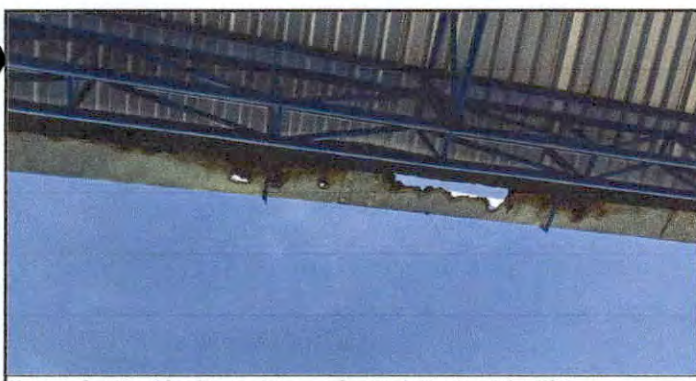
Foto 5: Sustitución de canaletas en frente del techo del edificio escolar.
