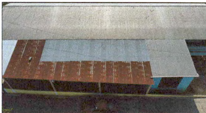
Foto 4: Sustitución de lámina acanalada por lámina troquelada, techo del patio del edificio escolar, módulo 1.
