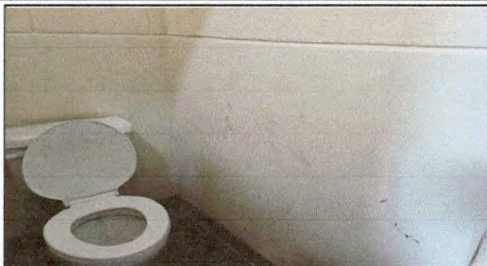
Foto 1: Colocación de azulejo en las paredes del baño de niños y en el baño de niñas.
