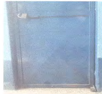
Foto 4: Mantenimiwento y aplicación de pintura
