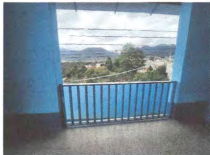
Foto 1: Mantenimiento a barabdas de metal
