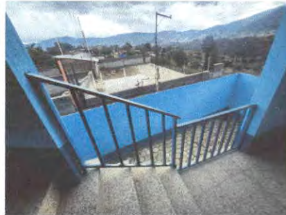
Foto 2: Mantenimiento a barabdas de metal
