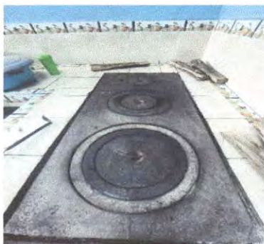
Foto 3: Plancha en mal estado
