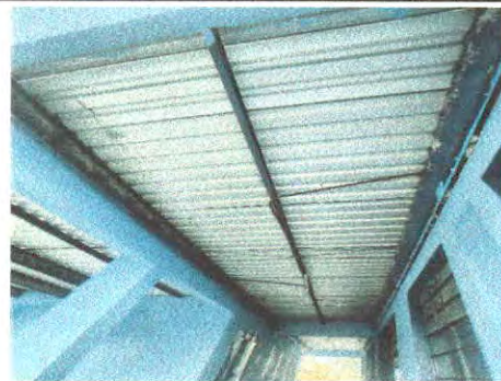
Foto 6: Mantenimiento de estructura de metal
