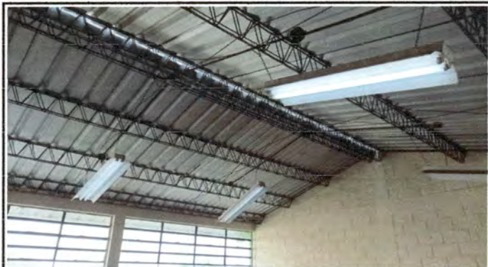
Foto 3: Vista de instalación eléctrica de aulas a remozar.
