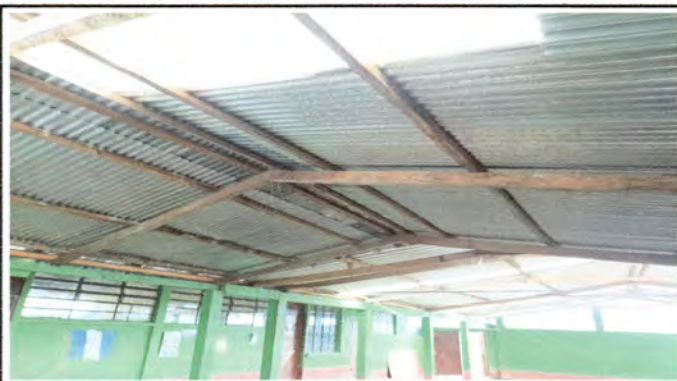
Foto 2: Segunda vista del techo de patio a remozar.
