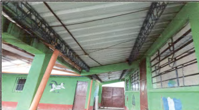
Foto 4: Vista de instalación eléctrica de corredor a remozar.
