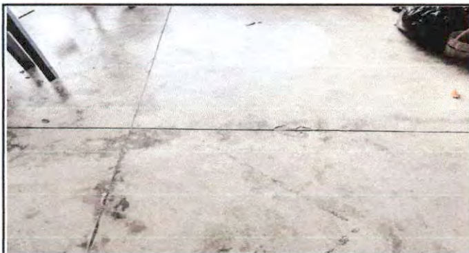
Foto: 4 Sustitución de piso de aula planta baja
