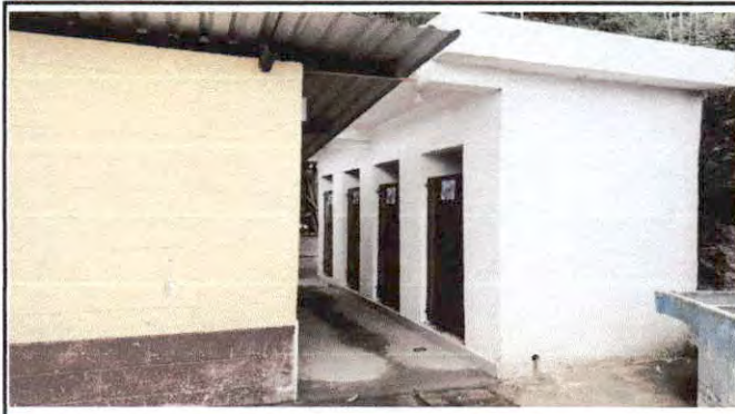
Foto: 2 Pintada de modulo de baños planta alta
