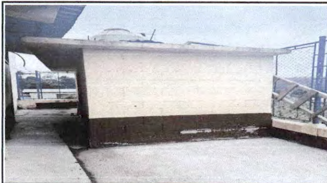
Foto: 6 Pintada de módulo de baños planta baja
