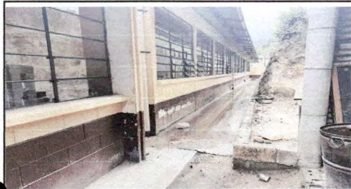
Foto: 1 Pintada de paredes de aula exteriori planta alta
