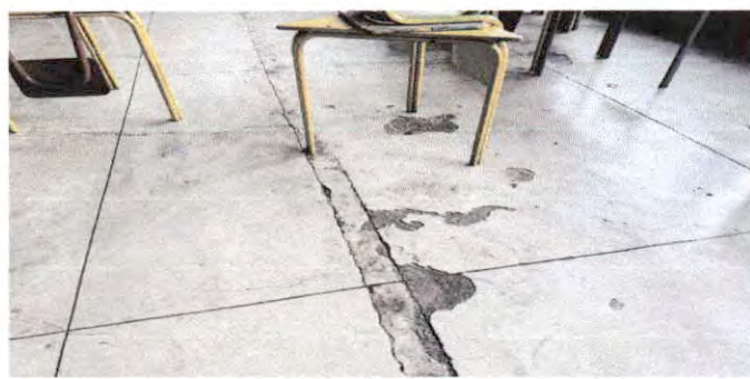
Foto: 3 Sustitución de piso de aula planta baja
