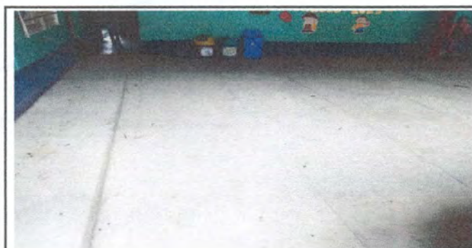
Foto 9: sustitucion de piso a duela en patio
