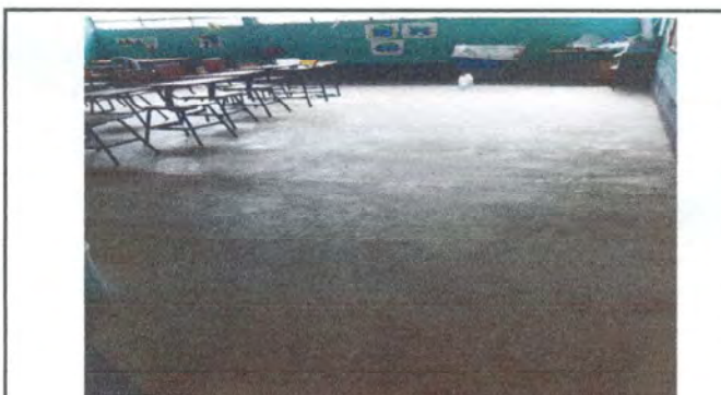
Foto 4: Aula 4 sustitucion de cemento a piso a duela
