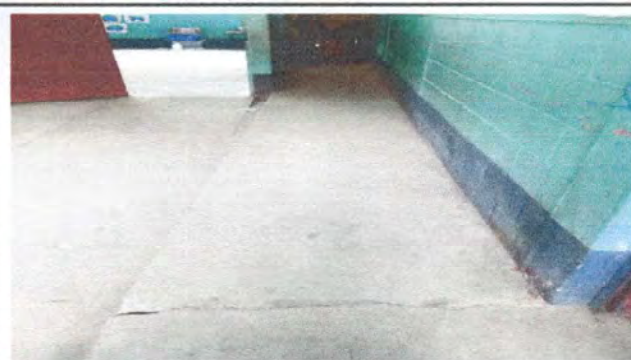
Foto 8: sustitucion de piso a duela en pasillo
