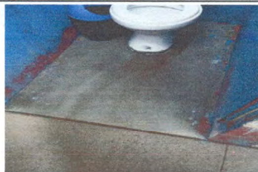
Foto 14: baño 2 sustitucion de piso a duela
