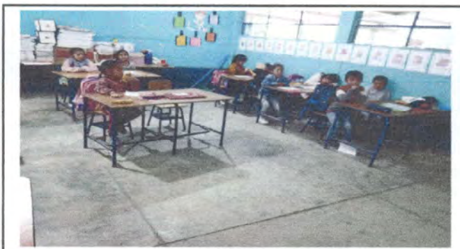
Foto 6: Aula 6 sustitucion de cemento a piso a duela
