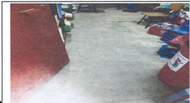
Foto 7: Aula 7 sustitucion de piso a duela
