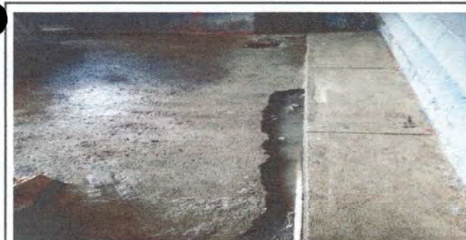
Foto 11: sustitucion de piso a duela en area de pila
