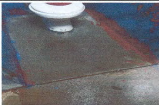
Foto 13: baño 1 sustitucion de piso a duela
