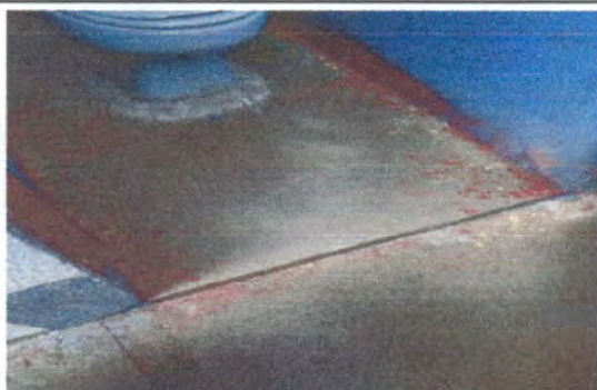
Foto 15: baño 3 sustitucion de piso a duela
