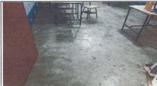
Foto 2: Aula 2 sustitucion de cemento a piso a duela
