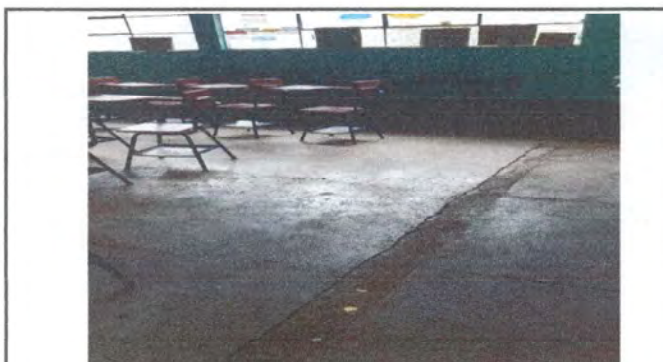
Foto 3: Aula 3 sustitucion de cemento a piso a duela
