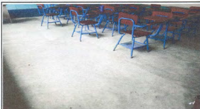
Foto1: Aula 1 sustitucion de cemento a piso a duela
