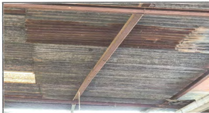
SUSTITUCIÓN DE LAMINAS ACANALADAS POR LAMINAS TROQUELADAS
