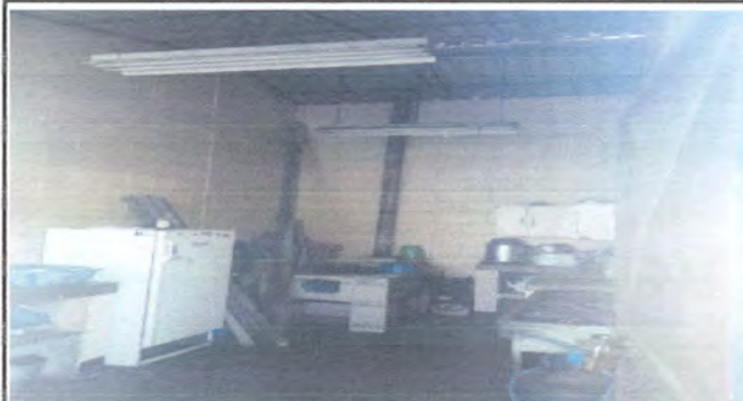
Foto 2: Sustitución de piso de cemento, instalación de azulejo y repello de paredes en cocina.
