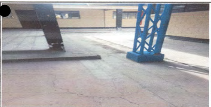
Foto 5: SITUACION ACTUAL (CONSTRUCCION DE CAJA PARA DRENAJE)
