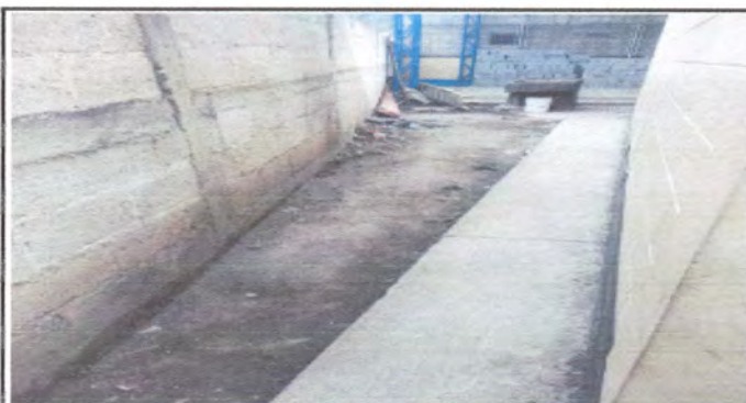
Foto 6: SITUACION ACTUAL (CONSTRUCCION DE PAVIMENTO HIDRAULICO)
