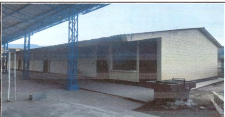
Foto 3: SITUACION ACTUAL (PINTURA EN PAREDES)
