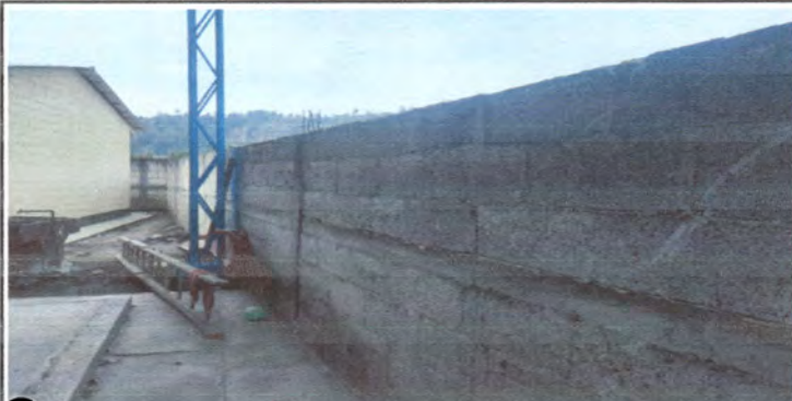
Foto 1: SITUACION ACTUAL (REPARACION DE MURO DE BLOCK) E INSTALACIÓN DE CERCO PERIMETRAL DE MALLA.
