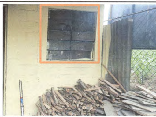
Foto 2: Sustitucion de ventana existente por ventana de PVC, en cocina
