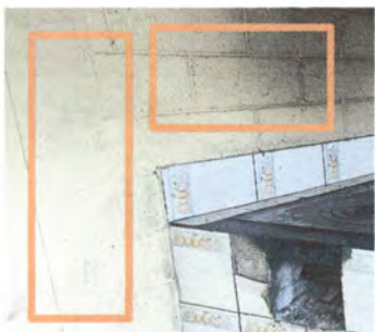
Foto 7: Repello de paredes interiores de cocina
