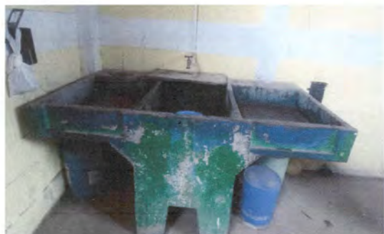
Foto 9: Sustitución de pila deteriorada por nueva
