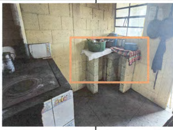
5. Sustitución de mesa de trabajo de concreto
