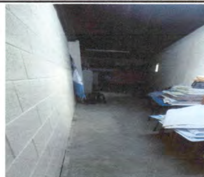
Foto 9: Sustitución de piso por piso ceramico en direccion
