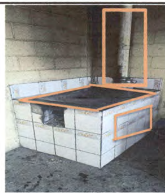
Foto 4: Sustitucion de plancha de leña incluyendo tubos de chimenea
