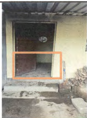
Foto 3: Sustitución de piso por piso ceramico antideslizante en cocina
