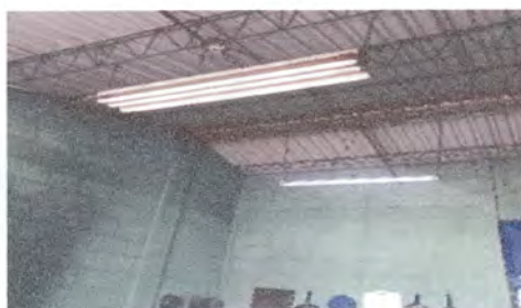
Foto 3: Reparación del sistema eléctrico de la cocina.
