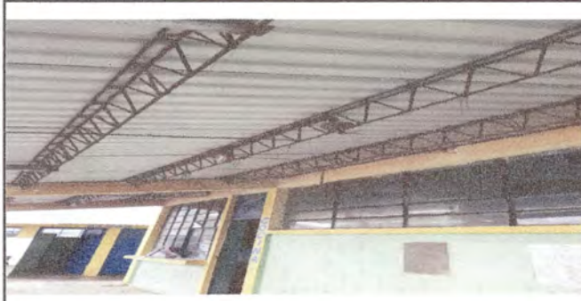
Foto 1: Corredor y patio Cambio del servicio electrico
