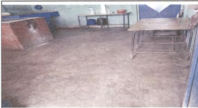
Foto 3: Sustitución de piso de cemento por piso granito en la cocina.
