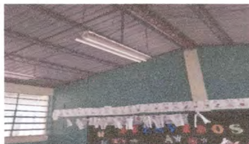
Foto 2: Reparación del sistema eléctrico de las aulas de preprimaria y primero.
