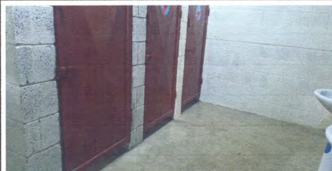
Foto 6: Sustitucion de piso cerámico antideslizante en servicios sanitarios.
