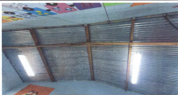
Foto1: Sustitucion de techo de lamina por lamina troquelada calibre 26"
