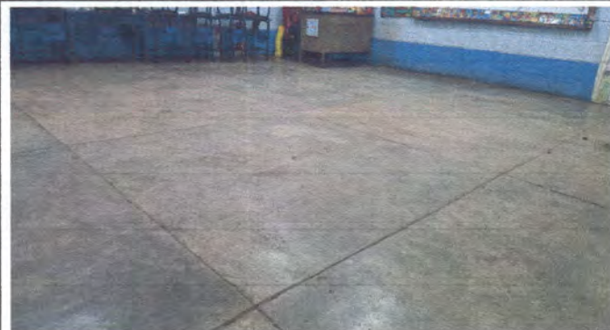
Foto 4: Sustitucion de piso alisado por piso ceramico
