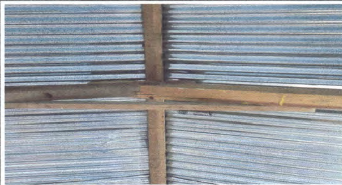
Foto 2: Sustitucion de viga de madera por estructura metalica con costaneras
