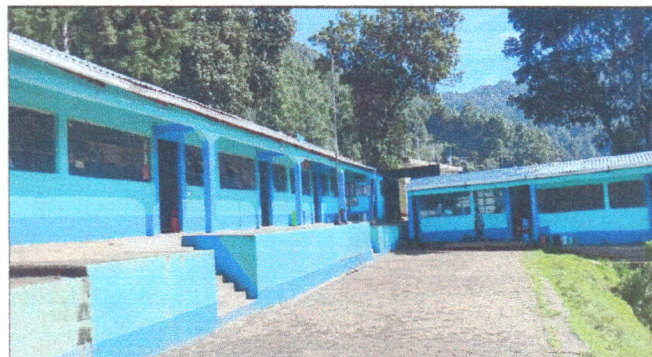
Foto 4: Sustitución de estructura metálica y vidrios por ventana de PVC blanco y vidrio de 5 mm claro de 6 aulas e instalación de balcones de estructura metálica de 3 aulas
