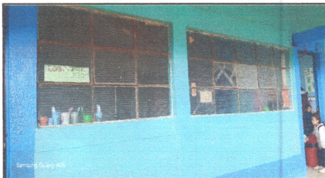
Foto 3: Sustitución de estructura metálica y vidrios por ventana de PVC blanco y vidrio de 5 mm claro de 6 aulas e instalación de balcones de estructura metálica de 3 aulas
