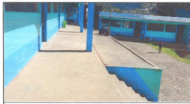
Foto 6 : Sustitución de piso de concreto por piso de granito de corredor frontal de 6 aulas de 58.50 metros cuadrados
