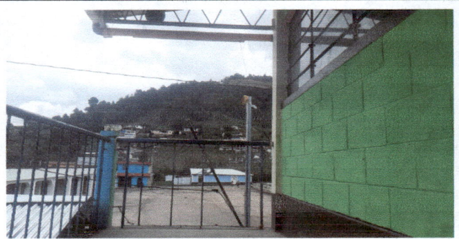
FOTO 8: SUSTITUCON DE BARANDA DE METAL
