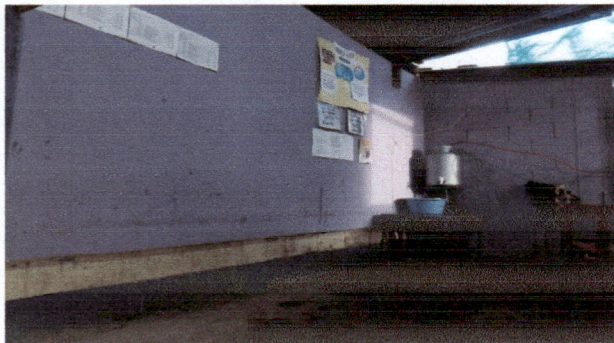
Foto 1 : SUSTITUCION DE PARED DE TABLAYESO POR PARED DE FIBROCEMENTO DE 22 M2
