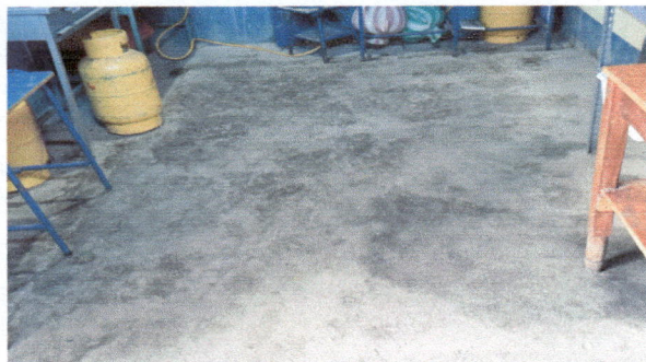
Foto 3: SUSTITUCION DE TORTA DE CEMENTO POR PISO CERAMICO.
