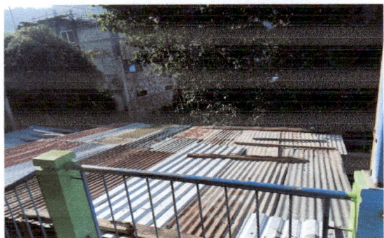
Foto 5: SUSTITUCION DE LAMINAS ACANALADAS POR LAMINAS TROQUELADAS CALIBRE 26
