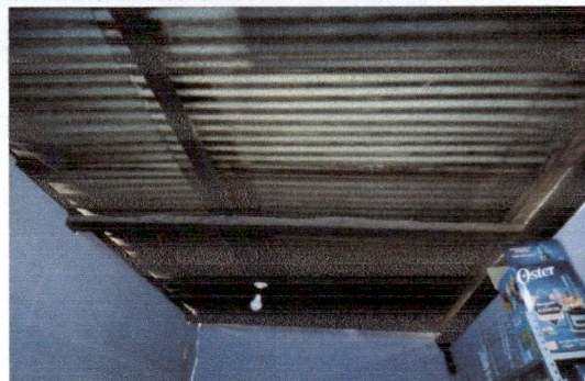
Foto 2: SUSTITUCION DE LAMINA ACANALADO POR LAMINA TROQUELADA Y ESTRCUTRA DE MADERA POR ESTRUCTURA METALICA
