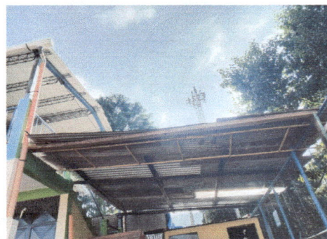
Foto 6: SUSTITUCION DE GALERA DE ESTRUCTURA DE COSTANERA EN DETERIORO POR ESTRUCTURA DE METAL
