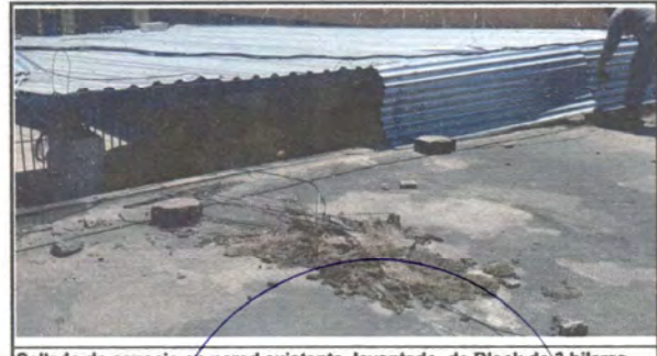
Sellado de espacio en pared existente, levantado de Block de 3 hileras con medidas de 9.30 de largo * 3 metros de alto,
