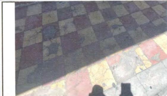
DEMOLISION DE PISO CEMENTO POR UNDIMIENTO E INSTACION DE PISO EN CORREDOR
