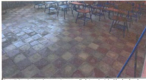
Demolicion de piso de cemento por undiminto e instalación de piso de Granito 33*33 de aula No. 3 y corredor
