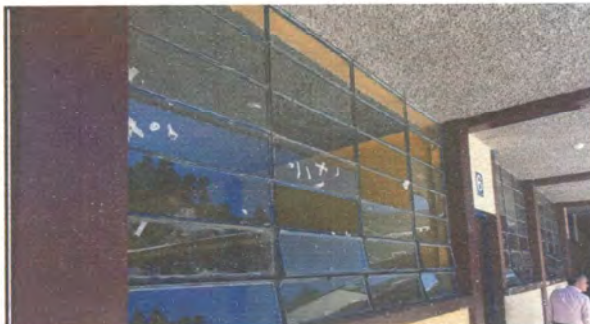
VENTANERIA, Reparación de ventanas de aula No. 03, con aplicación de pintura anticorrosiva y reposición de vidrios con medidas de 2mts. de largo * 1.20 de largo.
