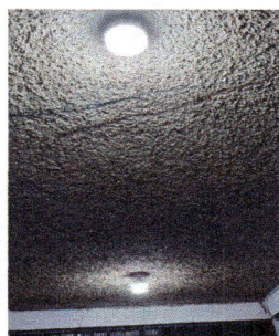
Foto 11: Pintura techo texturizado
