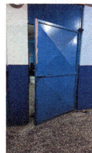
Foto 6: Pintura puertas de metal
