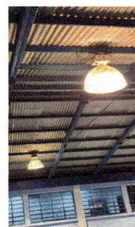
Foto 10: Mantenimiento lámparas cancha deportiva
