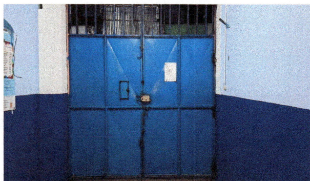
Foto 3: Pintura de porton
