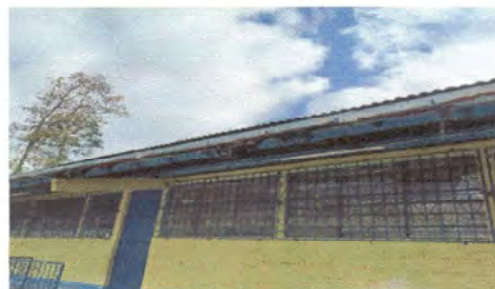
Foto 8: Cambio de canales
