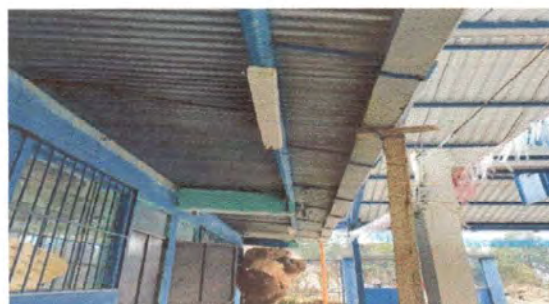
Foto 10: Cambio de lámparas
