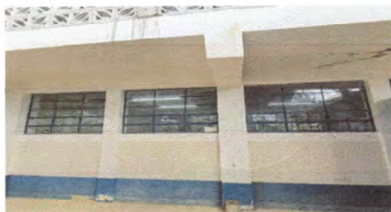
Foto 5: Colocación de balcones
