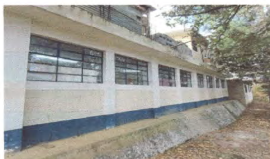
Foto 4: Colocación de balcones
