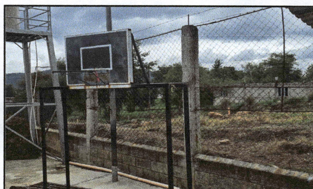
Foto 6: Sustitucion de maya
