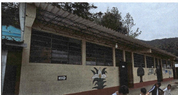
Foto 5: Sustitucion de pintura del establecimiento. (Foto 2)
