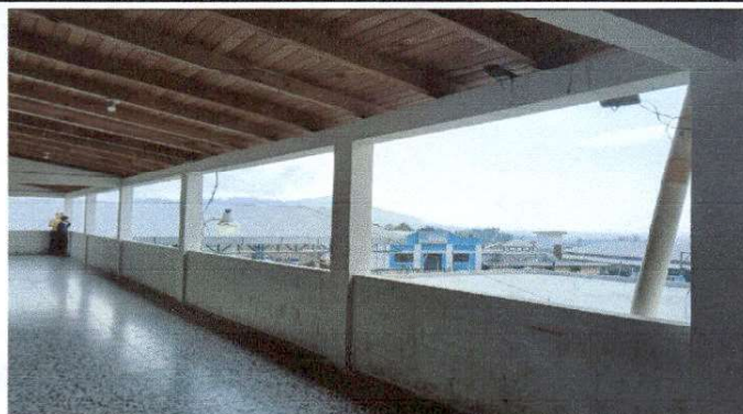
Foto 2: Colocación de barandas de metal
