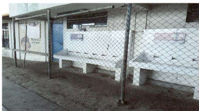
Foto 4: Cambio de mallas, por baranda de metal
