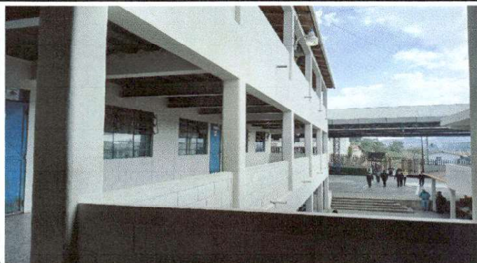
Foto 1: Colocación de barandas de metal
