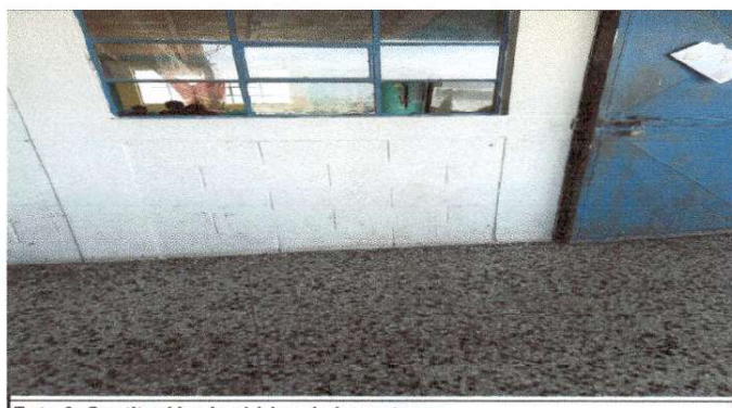
Foto 6: Sustitución de vidrios de la ventana
