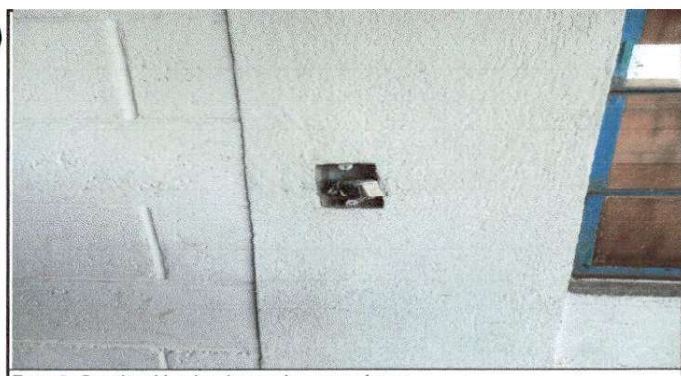
Foto 5: Sustitución de placas de apagadores
