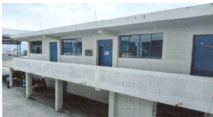
Foto 3: Colocación de barandas de metal
