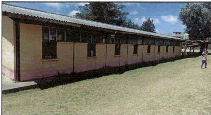
Instalación de balcones módulo 1
