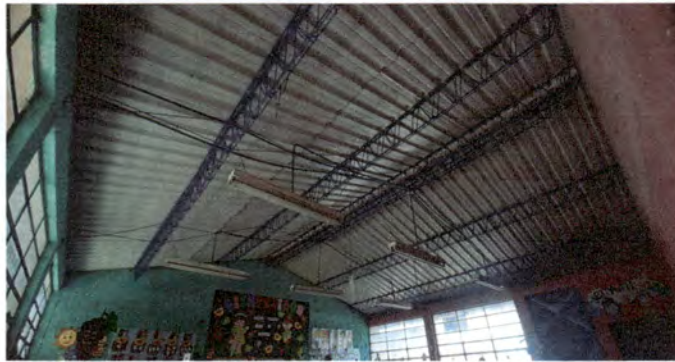
Sustitución de lamparas a lámparas Led en módulo 4 aula 1
