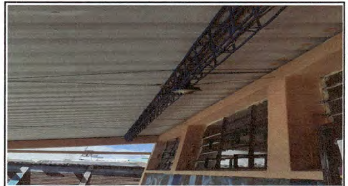
Foto 4: Sustitución de sistema electrico en módulo 4
