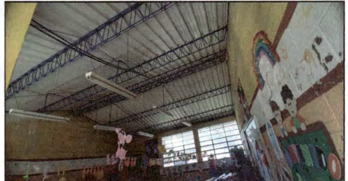
Foto 2: Sustitución de lámparas a lámparas Led en modulo 4 aula 2
