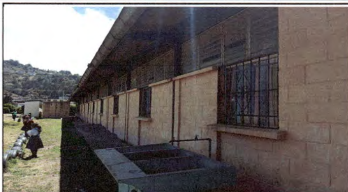
Foto 2: instalación de balcones módulo 2
