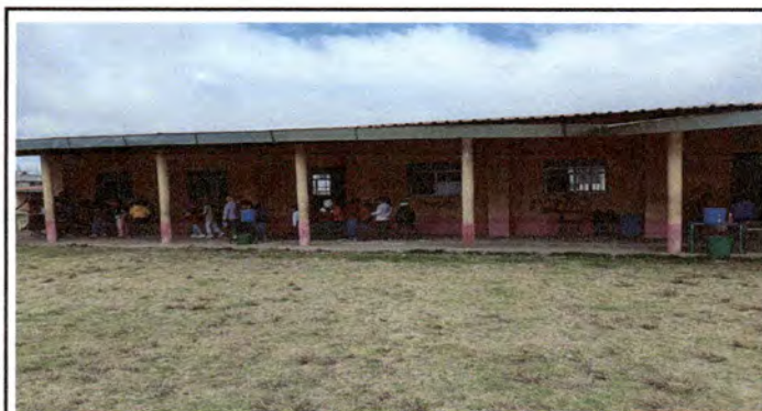
Foto 3: Sustitución de canal módulo 3
