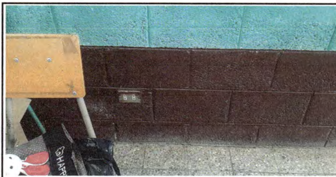
Foto 6: Cambio de tomacorrientes
