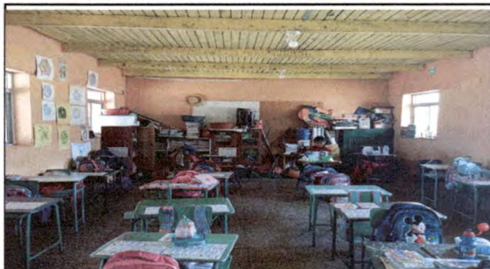
Foto 2: sustitución de pintura en aula
