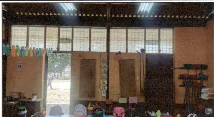
Foto 2: sustitución de pintura en aula
