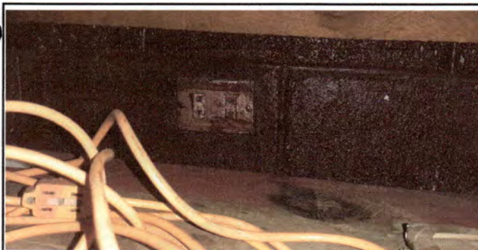
Foto 5: Cambio de toma corrientes
