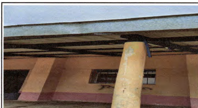
Foto 4: Sustitución de bajada de agua módulo 3
