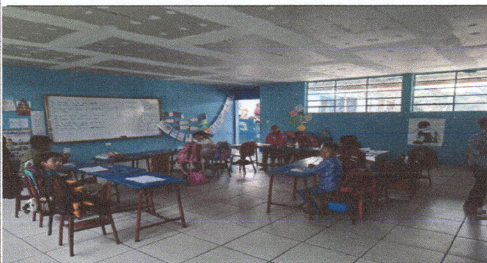
Foto 3: Pintada de aula interior, exterior y entechado No. 3
