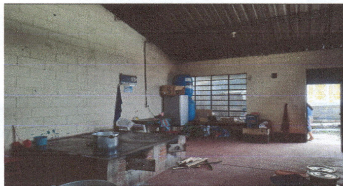
Foto 4: Cambio de piso de cocina
