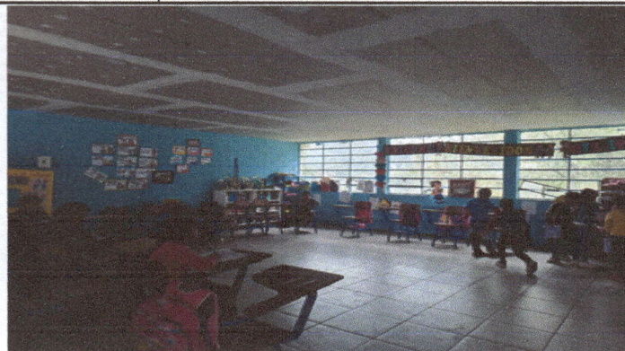
Foto 2: Pintada de aula interior, exterior y entechado No. 2
