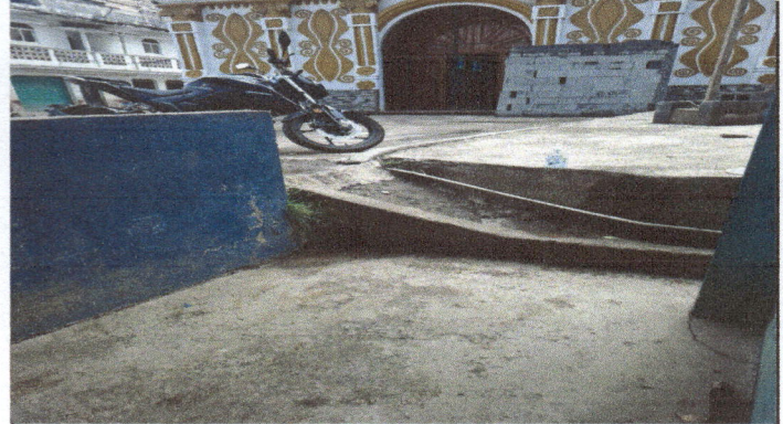
Foto 2: Se realizaran gradas en la entrada del modulo No. 3
