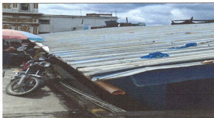
Foto 3: Pintado de entechado y cambio de tubo de caída de agua o canaleta
