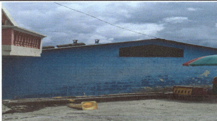
Foto 2: Pintada de cocina exterior e interior
