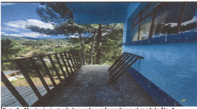
Foto 5: Mantenimiento de baranda y reforzada en el modulo No. 1
