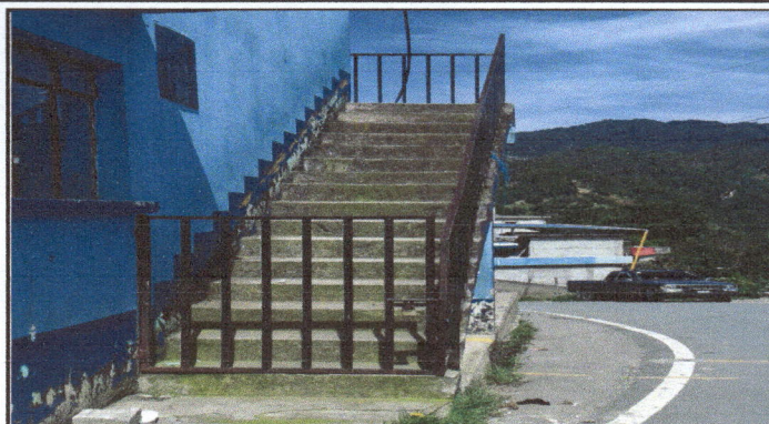
Foto 2: Sustitución y colocación de baranda nueva de la puerta de las gradass
