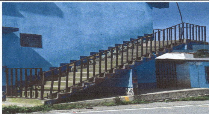
Foto1: Sustitución y colocación de baranda nueva de las gradass
