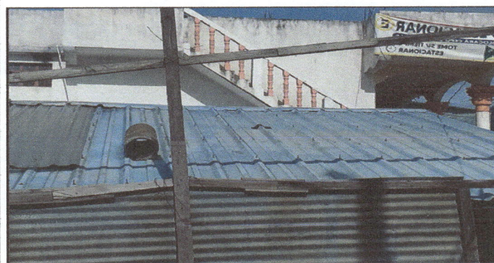
Foto 5: Pintado de entechado de la cocina
