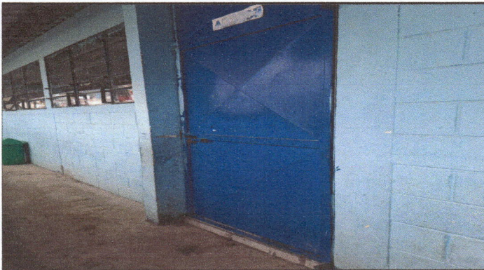
Foto 3: Instalación de chapas en cuatro puertas y pintadas.
