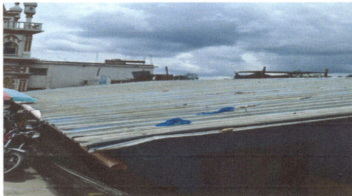
Foto 4: Cambio de tres laminas troqueleadas
