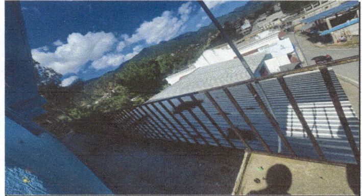
Foto 4: Instalación de baranda en el modulo No. 1
