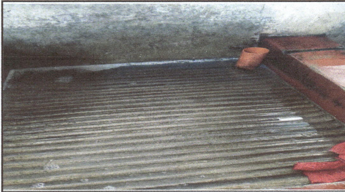
Foto1: Se instalara una boquilla en el labadero dela cocina
