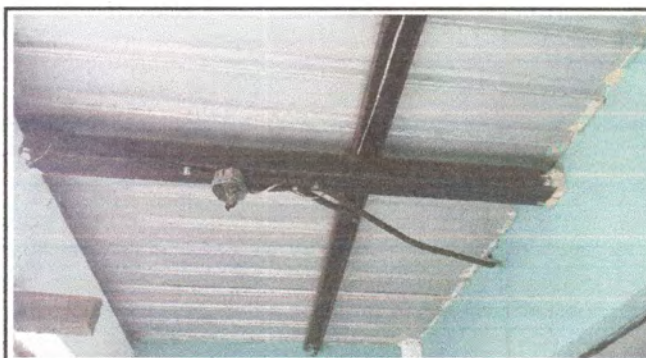
Foto 10: Instalación de plafoneras y focos ahorradores
