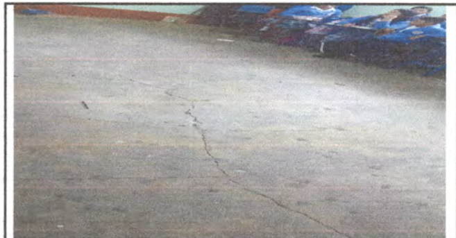
Foto 6: Sustrucción de piso de concreto en el aula de quinto primaria aula no.3 segundo nivel
