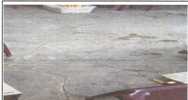
Foto 4: Sustrucción de piso de concreto en la bodega de alimentos, segundo nivel.
