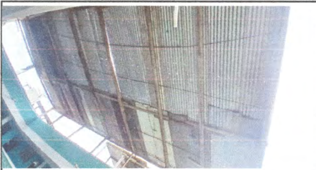
Foto 3: Sustrucción de cubierta de lámina
