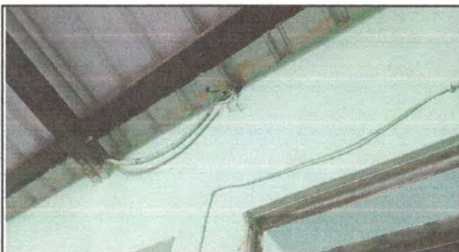
Foto 9: Sustrucción de ducto eléctrico
