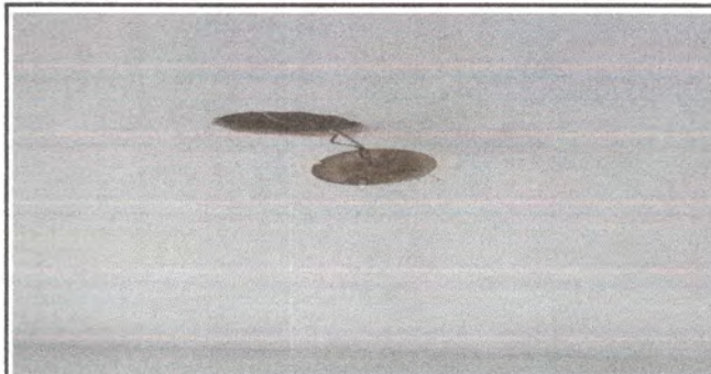
Foto 8: Sustrucción de plafonera aula 1
