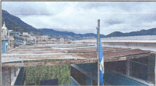
Foto 1: Sustrucción de cubierta de lámina en mal estado por lámina troquelada
