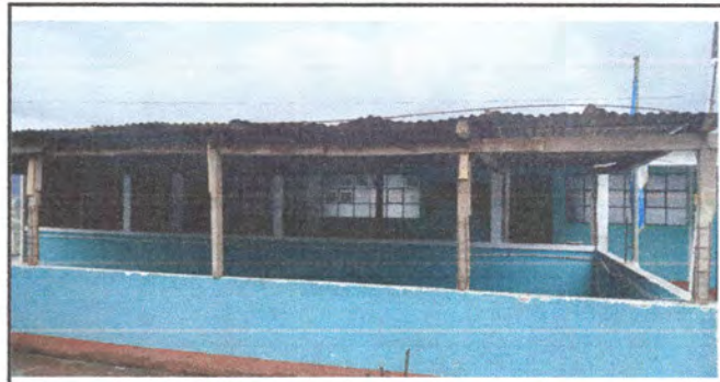
Foto 2: Sustrucción de estructura portante de techo de madera
