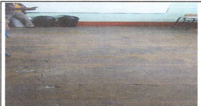
Foto 5: Sustrucción de piso de concreto en el aula de sexto primaria, aula del segundo nivel.
