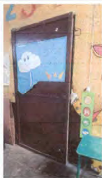
Foto 1: Colocación de puerta de metal de 101x213 cm, Párvulos 5 B
