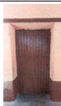
Foto 6: Colocación de puerta de metal de 106 x 2014 cm, Quinto A
