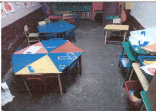
Foto 1: Instalación de piso cerámico, Párvulos 5 "B"
