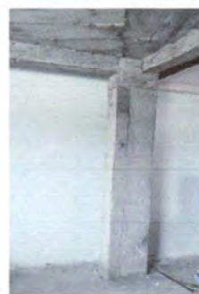
Foto 4: Repello de columnas antiguo, Segundo A
