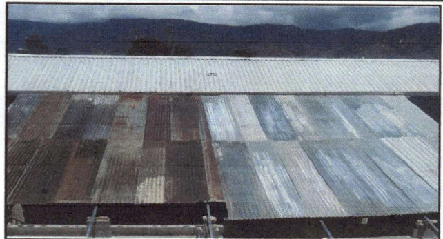
Foto 2: Parte de arriba lado sur del entechado
