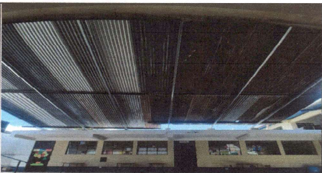
Foto 5: Foto frontal de donde se coloca varandal.
