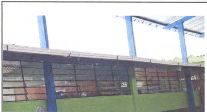
Sustitución de canales y bajadas de agua
