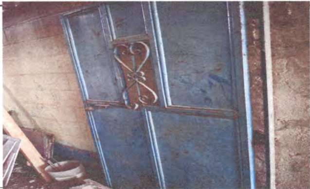
Mantenimiento y reparación de puerta bodega 2
