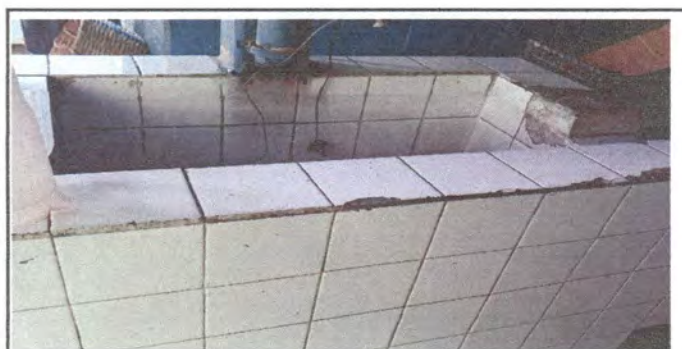
Remozamiento de azulejo de pila de cocina
