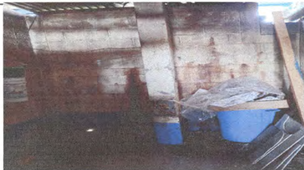
Remozamiento de piso de bodega 2
