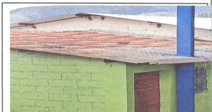
Sustitución de canales , bajadas de agua y sustitución de lamina de techo
