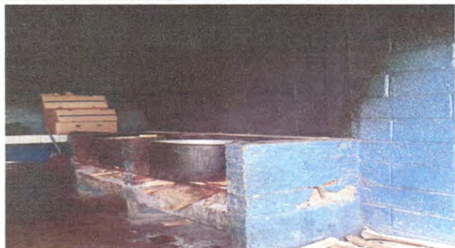
Remosamiento de area de cocina
