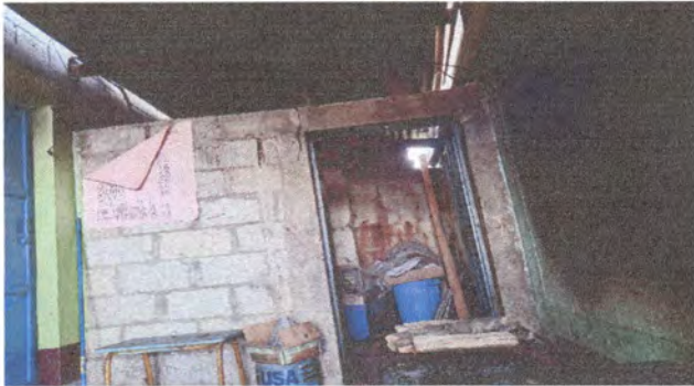
Remosamiento de area de bodega 2
