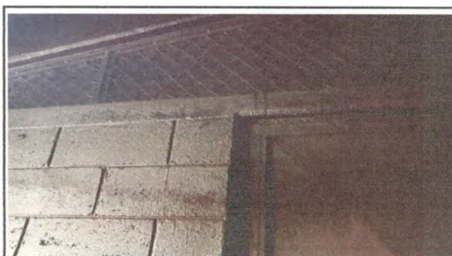
Pintura de paredes de cocina
