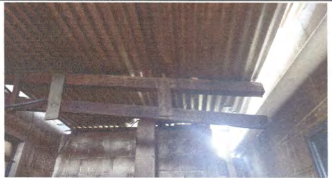
Sustitución de techo de bodega 2
