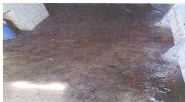
Remosamiento de piso de cocina
