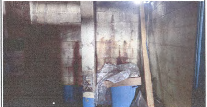
Remozamiento pintura de bodega 2
