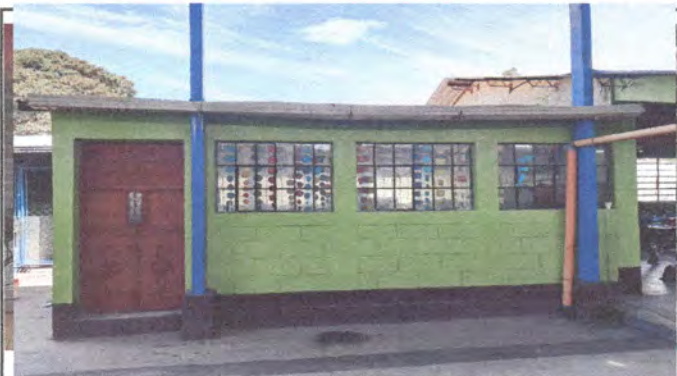
Sustitución de canales y bajadas de agua
