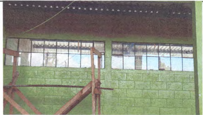
Balcones de proyector de ventana de 2.67 m2 ventana 1
