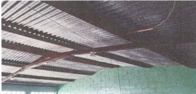
Sustitución de tendales aula 3
