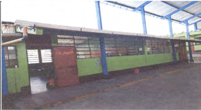
Sustitución de canales y bajadas de agua
