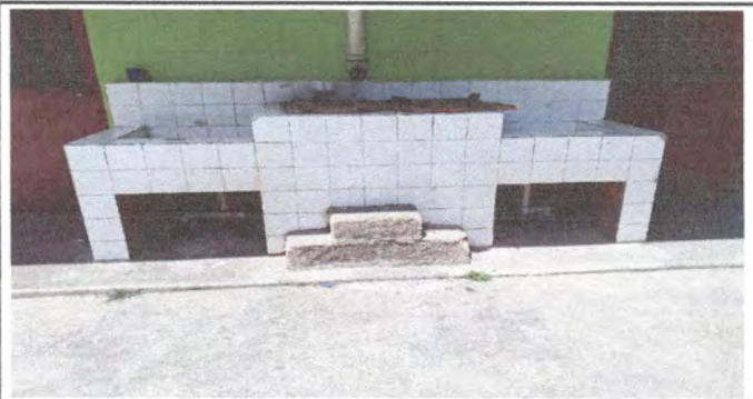
Remozamiento de azulejo de pileta de estación de lavado de manos
