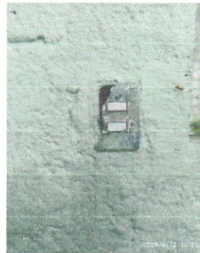
Foto 14: Reparación de sistema electrico del establecimiento
