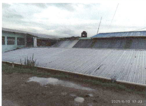
Foto 5: Mejoramiento de iluminacion natural en aulas 7, 8 y 9 a traves de la instalacion de 3 laminas tragaluz de 10 pies cada uno. Uno por aula
