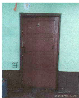
Foto 9: Sustrucion de puerta de madera a puerta de metal en aula No.8
