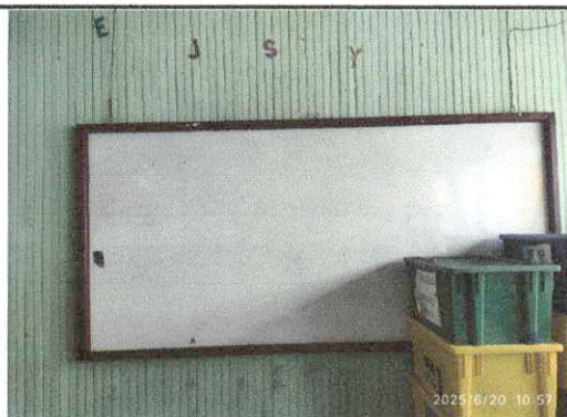
Foto 3: Division de tablayeso e colocacion de puerta para bodega de educacion fisica
