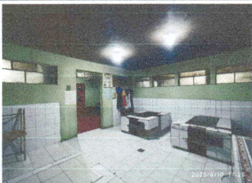
Foto 15: Remozamiento de piso de cocina
