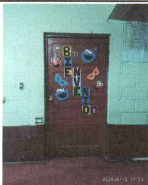
Foto 7: Sustrucion de puerta de madera a puerta de metal en aula No.10
