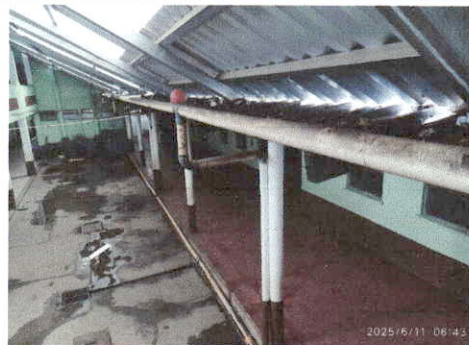
Foto 12: Mejoramiento de canales de tuvo pvc 3" a canales PVCde mejor captacion de caudal
