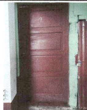
Foto 10: Sustrucion de puerta de madera a puerta de metal en aula No.7
