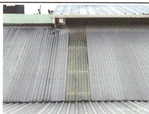
Foto 4: cambio de lamina tragaluz acanalado de 14 pies, por deterioro del alterior
