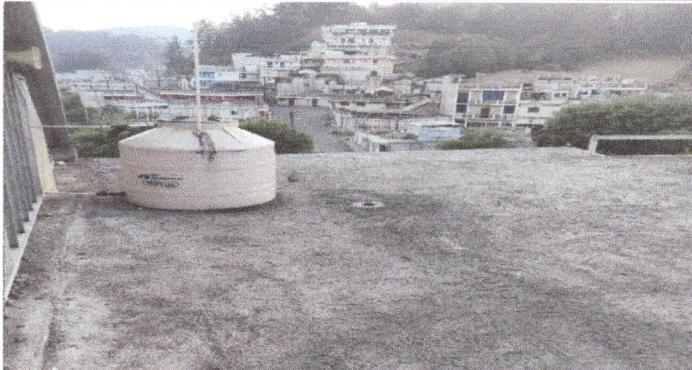
Impermeabilización de terraza de cemento en servicio sanitario
