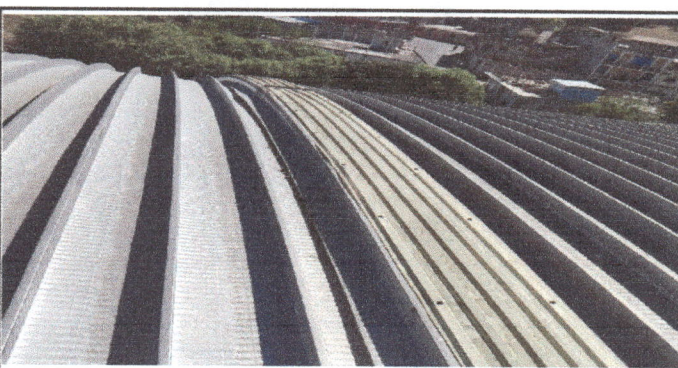
Sustitución de traga luces de techo por policarbonato de salón y bodega
