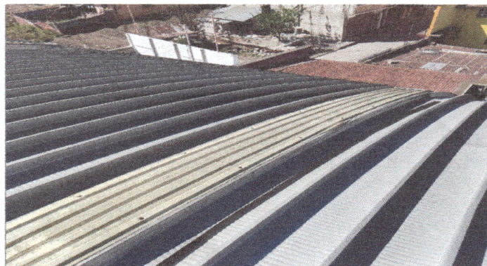
sustitucion de traga luces de techo por policarbonato del salon
