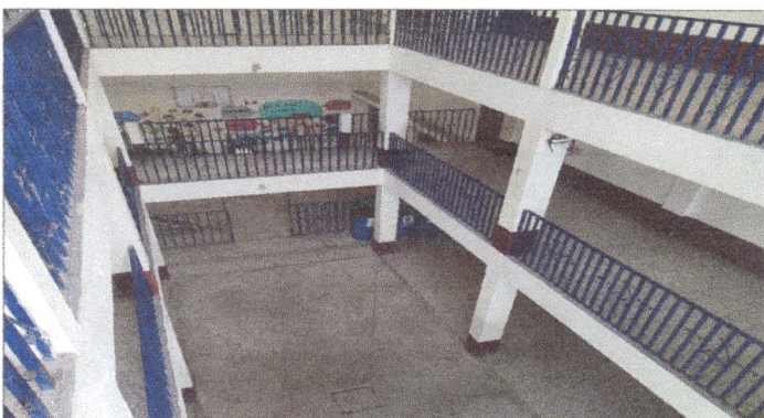
Mantenimiento y pintado de barandas del primer nivel al tercer nivel
