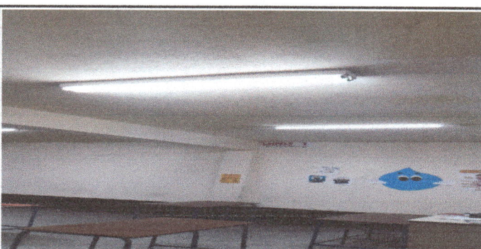
Mantenimiento de lamparas energia electrica aulas
