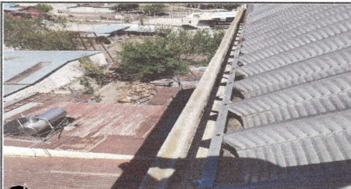
de canales y bajadas de aguas pluviales
