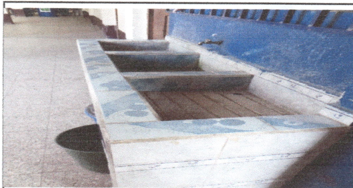
Mantenimiento del drenaje de la pila
