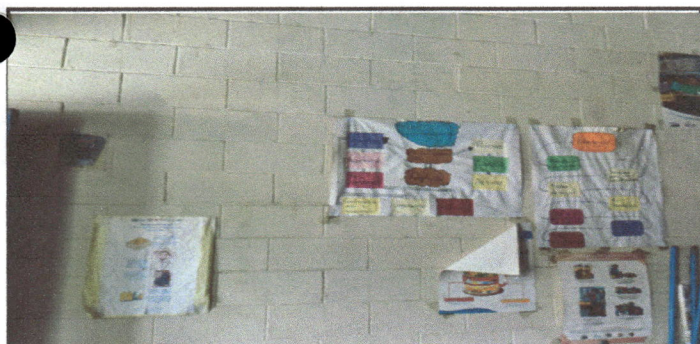
Foto 3: REPELLO DE PAREDES
