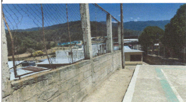
Foto1: MEJORAMIENTO DE CIRCULACIÓN PERIMETRAL
