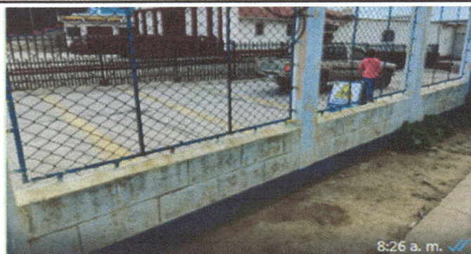
Foto 4: REPELLO DE CIRCULACIÓN
