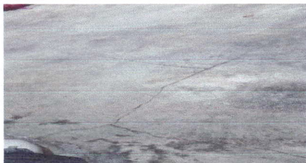
Foto 7: Cambio de piso de bodega
