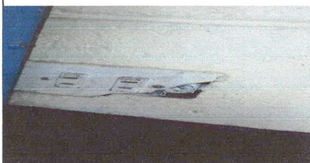
Foto 3: Cambio de tomacorrientes y apagadores en aulas
