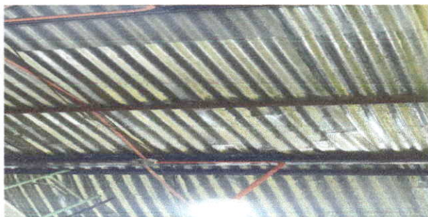
Foto 1: Cambio de láminas en los servicios sanitarios
