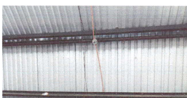
Foto 4: Cambio de sistema eléctrico y sellado de láminas en aulas
