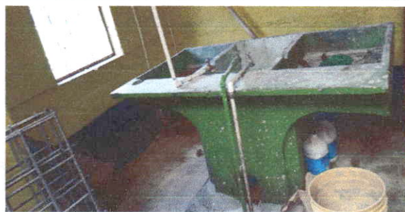
Foto 6: Sustitución de pila y drenaje
