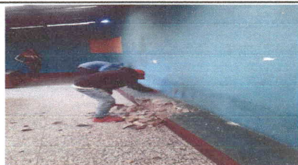
Foto 5: Cambio de piso en cocina y bodega
