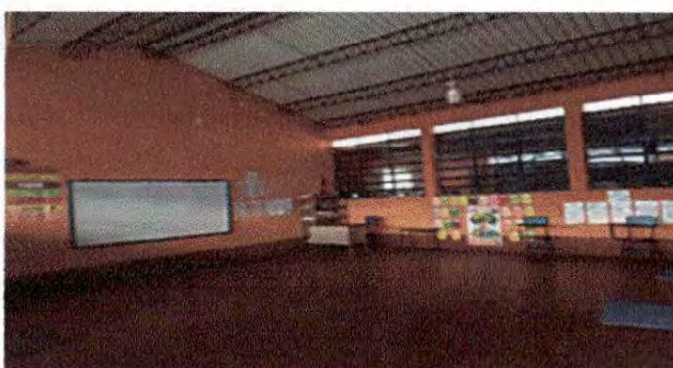
Foto 6: Pintura en muros interiores
