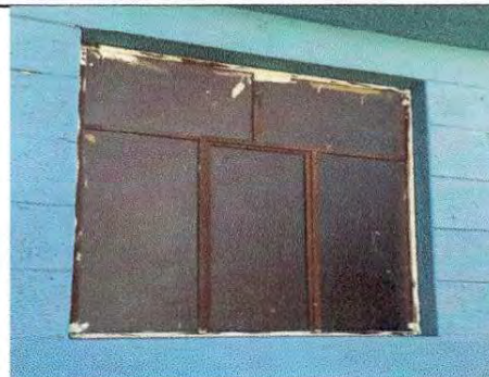
Foto 14: Instalación de balcones
