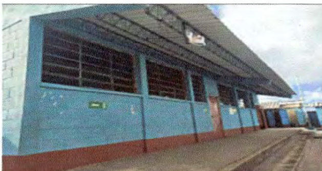
Foto 12: Instalación de balcones del aula de quinto y sexto
