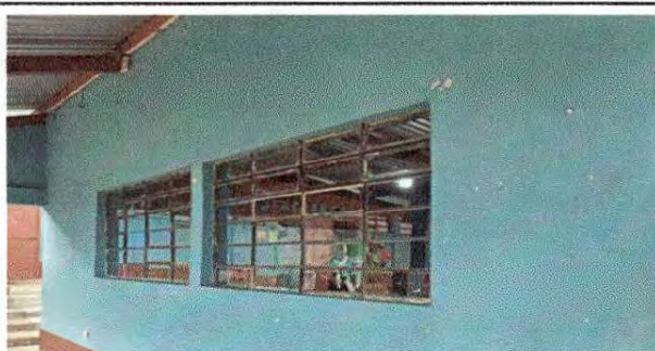
Foto 10: Instalación de balcones de primer grado.
