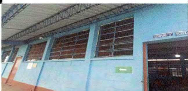
Foto 11: Instalación de balcones de segundo y tercero.
