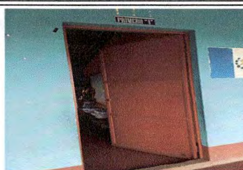
Foto 2: Sustrucción de una puerta de metal del aula de primero.
