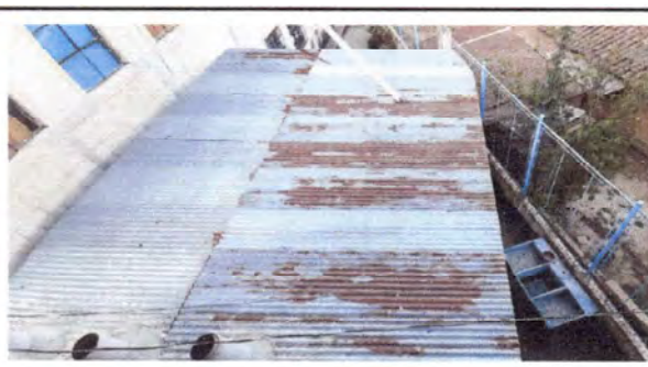
Foto 6: TECHO EXTERIOR DE COCINA 2 EN MAL ESTADO
