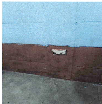
Foto 2: sustitucion de toma corrientes 35 y apagadores en las 7 aulas
