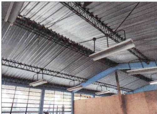
Foto 1: sustitucion de lamparas y cableado en 7 aulas
