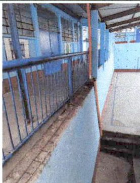
Foto 3: sustitucion y mantenimiennto de barandas del corredor de la escuela
