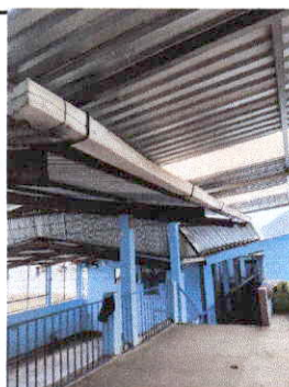
Foto 6: sustitucion de canales del corredor de las aulas.
