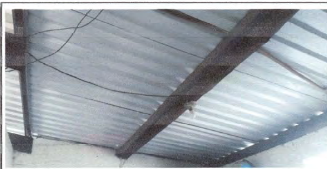
Foto 6: Colocacion de machimbre aula C
