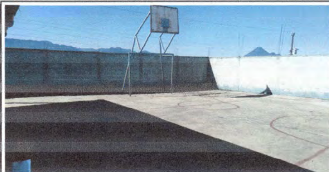
Foto 2: Instalacion de cerco perimetral de metal con tubos y maya en el patio del establecimiento (Circulación)
