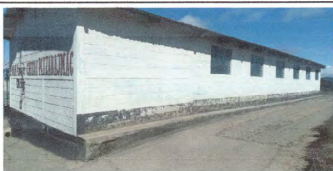
Foto 3: Pintada parte frontal y exterior del establecimiento y colocación de balcones aula C
