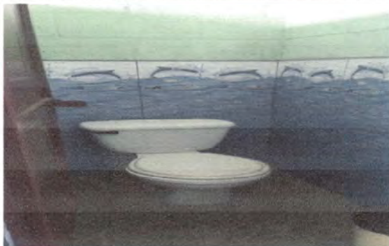
Foto7: Sustitucion de sanitarios en mal estado por Sanitarios blancos con botón.
