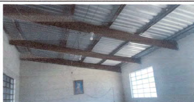
Foto 4: Colocacion de machimbre aula B
