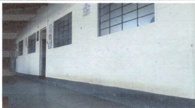
Foto 9: Instalacion de balcones con marco angular . Aula C
