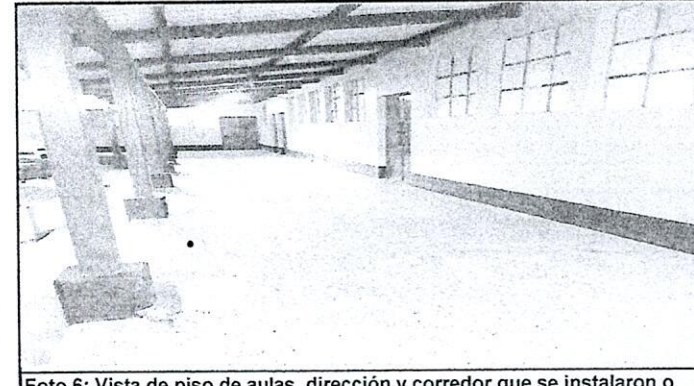
Foto 6: Vista de piso de aulas, dirección y corredor que se instalaron o sustituyeron.
