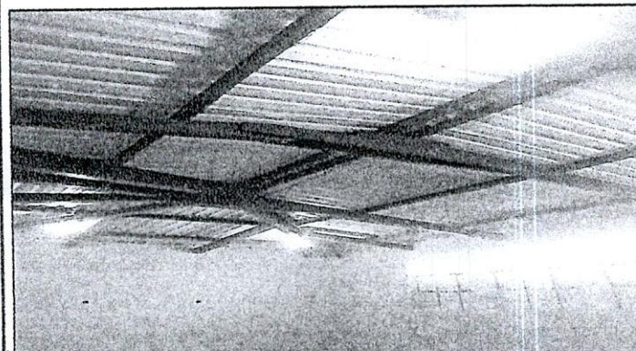
Foto 3: Vista de la estructura de techo de madera de aulas, dirección, bodega y corredor que se remozaron.
