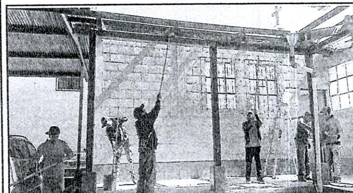
Foto 3: Vista de la estructura de techo de madera de aulas, dirección, bodega y corredor que se están remozando o pintando.
