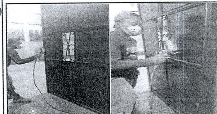
Foto 5: Vista de puertas de aulas que se están pintando.
