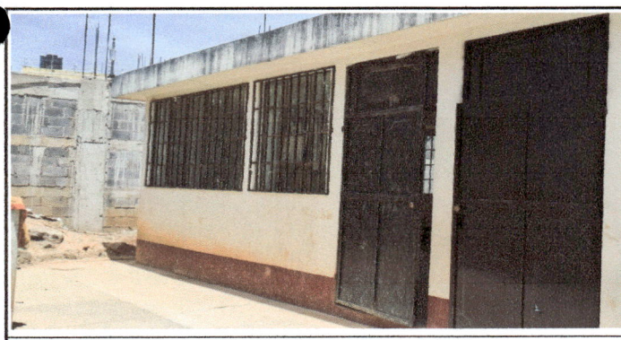
Foto 5: Vista de puertas de aulas que se estaran pintando.
