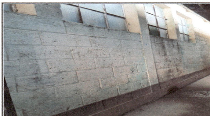
Foto 4: Vista de las paredes de aulas que se estaran pintando.
