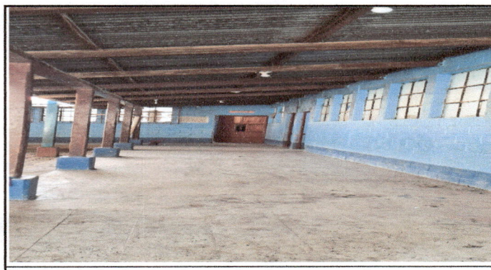
Foto 6: Vista de piso de aulas que se estaran remozando.
