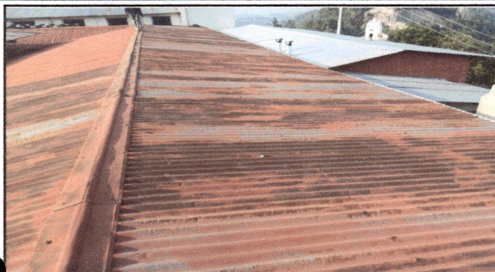
Foto 1: Vista de cubierta de techo, aulas que se remozarán con cubiertas de techos.
