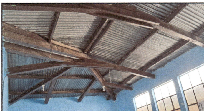
Foto 3: Vista de la estructura de techo de aulas de madera que se remozaran.
