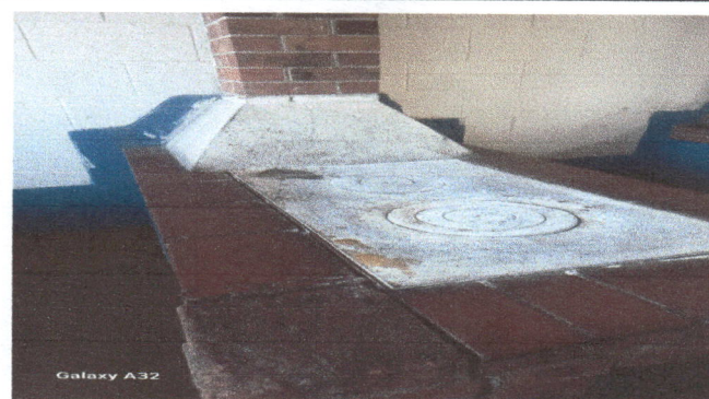
Foto 10: Estufa Rural 2 cambio de plancha y ladrillos por azulejo.
