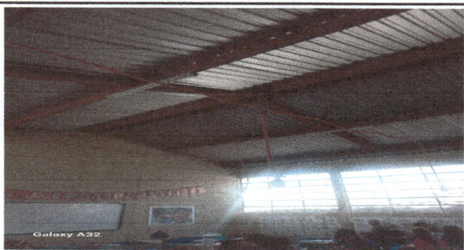
Foto 5: Aula 3 en esta área se pondrá machimbre, pintura y cambio de cableado eléctrico
