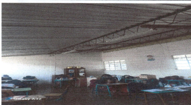
Foto 3: Aula 1 en esta área se pondrá machimbre, pintura y cambio de cableado eléctrico
