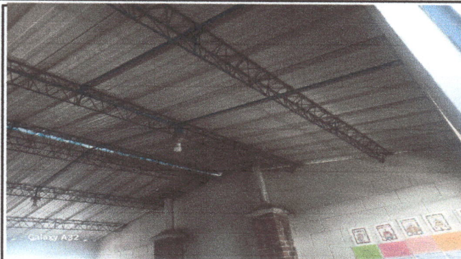
Foto 8: Cocina en esta área se pintará y cambio de cableado eléctrico.
