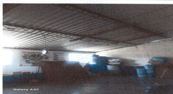
Foto 2: Bodega de alimentos, en esta área se pondrá machimbre, pintura y cableado eléctrico.
