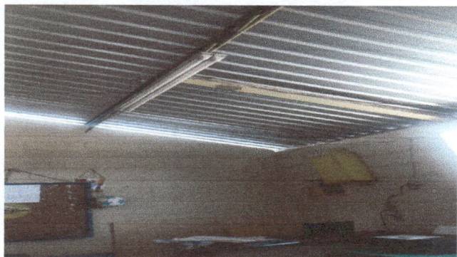
Foto 1: Dirección, en esta área se realizará cambio de cableado eléctrico y pintura del área.
