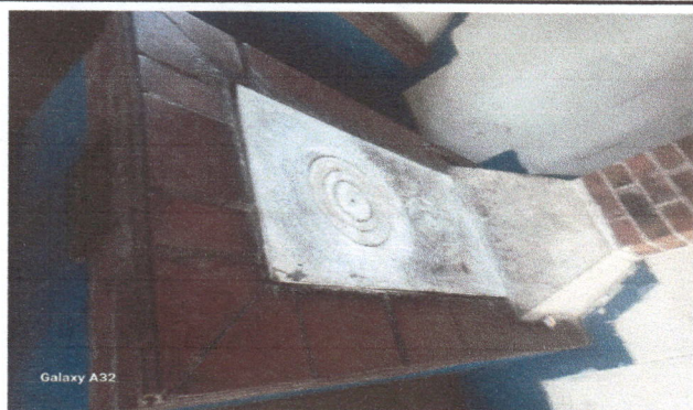
Foto 9: Estufa Rural 1 cambio de plancha y ladrillos por azulejo.
