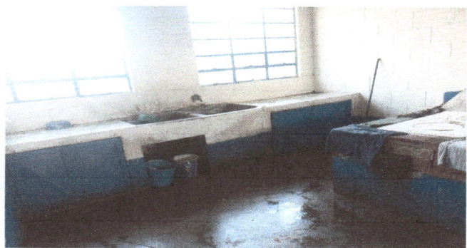
Foto 13: Cocina, colocación de azulejo en mesas de cocina.
