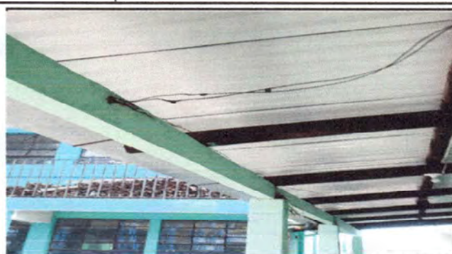
Foto 2: SUSTITUCION Y ENTUBADO DE CABLE EXTERIOR U CORREDOR DEL MODULO DE LOS GRADOS DE TERCERO, CUARTO, PREPRIMARIA A Y SEXTO
