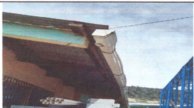
Foto 3: CAMBIO DE CANALES DEL MODULO DE PRIMERO Y BODEGA
