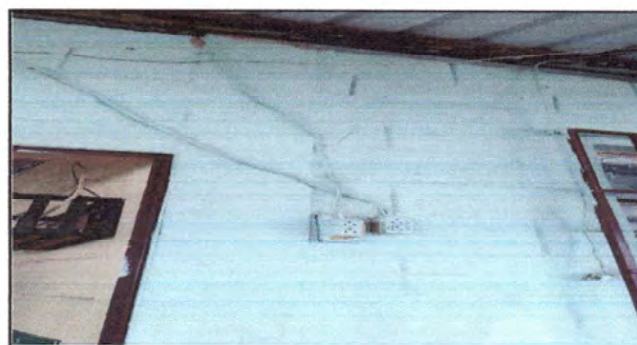
Foto 4: SUSTITUCION Y ENTUBADO DE CABLE EXTERIOR DEL MODULO DE LOS GRADOS DE QUINTO, PRIMERO A, SEGUNDO, PREPRIMARIA A Y DIRECCION
