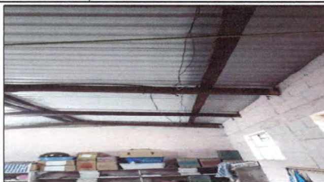
Foto 1: SUSTITUCION Y ENTUBADO DE CABLE INTERIOR DEL MODULO DE LOS GRADOS DE TERCERO, CUARTO, PREPRIMARIA A Y SEXTO
