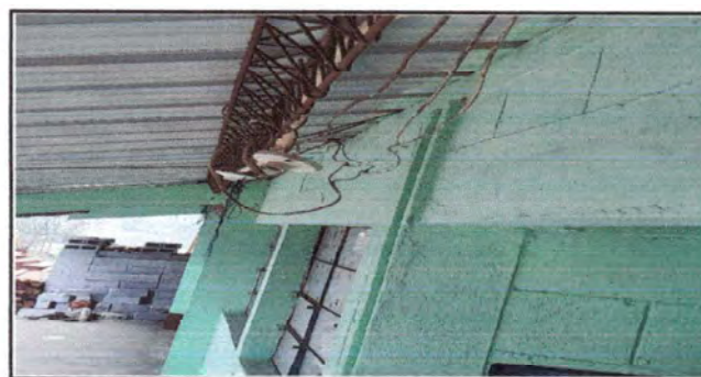
Foto 6: USTITUCION Y ENTUBADO DE CABLE EXTERIOR DEL MODULO DE PRIMERO A, LABORATORIO Y BODEGA
