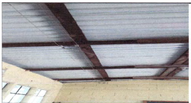
Foto 3: SUSTITUCION Y ENTUBADO DE CABLE INTERIOR DEL MODULO DE LOS GRADOS DE QUINTO, PRIMERO A, SEGUNDO, PREPRIMARIA Y DIRECCION
