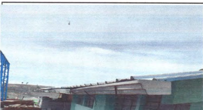
Foto 4: CAMBIO DE CANALES DEL MODULO DE PRIMERO Y BODEGA
