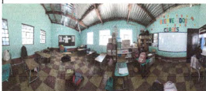
Foto 3: cambio de piso de aula
