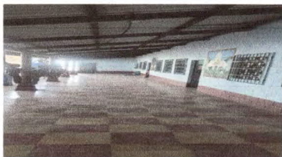
Foto 5: cambio de piso corredor
