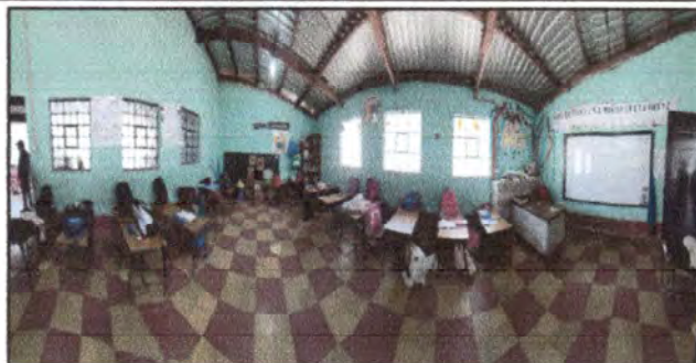
Foto 2: cambio de piso aula
