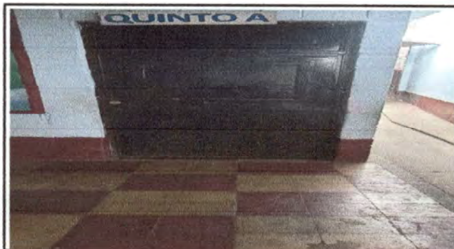
Foto 6: corte y pintura de puertas
