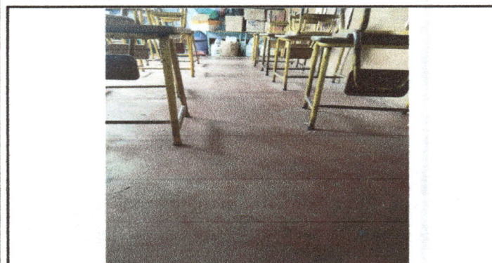
Foto 3: cambio de piso de aula
