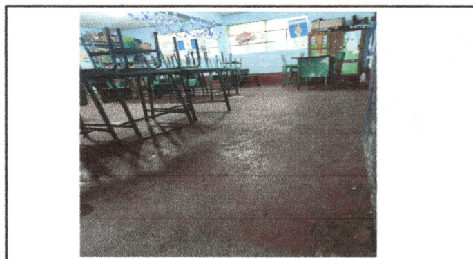
Foto 4: cambio de piso de aulas
