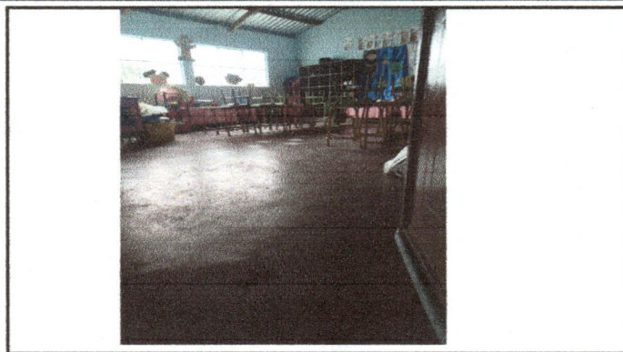
Foto 2: cambio de piso aula
