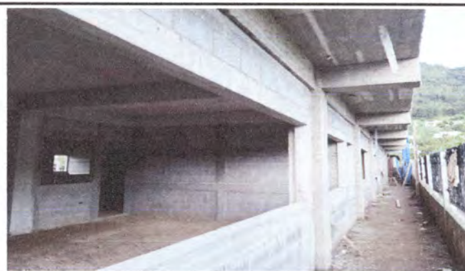
Foto 2: Instalación de ventans en aulas
