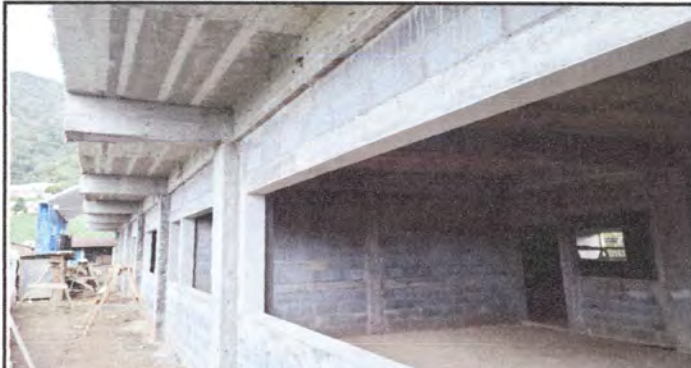
Foto 4: Instalación de ventanas en aulas
