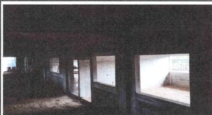
Foto 3: Instalación de ventanas y puertas en aulas
