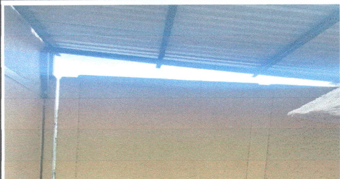
Foto 7 : LA PARED, HAY CERRAR LAS DOS AVERTURAS Y REPELLAR.
