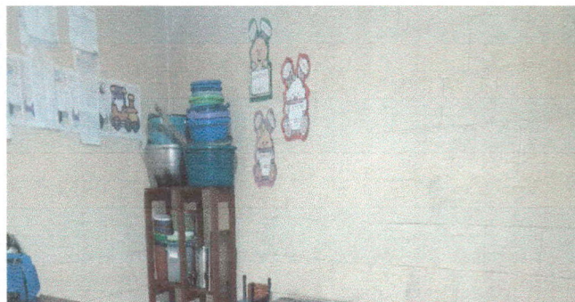
Foto 2: PAREDES DE COCINA, SE LE COLOCARA AZULEJO
