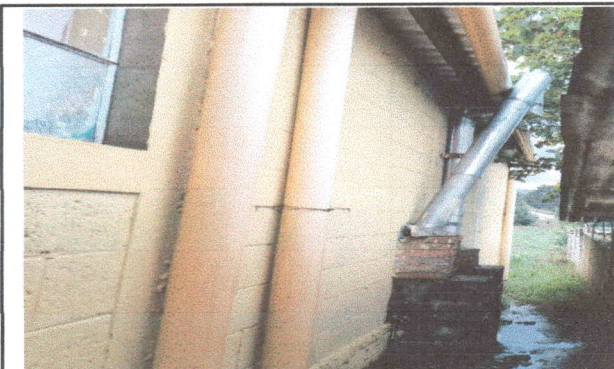
Foto 9: LAS CHIMENEAS DE LAS PLANCHAS, SE VAN HA CAMBIAR HECHAS DE BLOK
