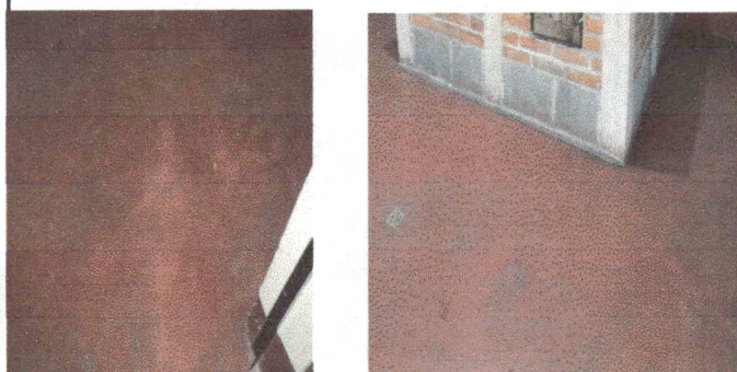
Foto 3: PISO DE BODEGA Y DE COCINA , SE LE COLOCARA PISO CERAMICO.
