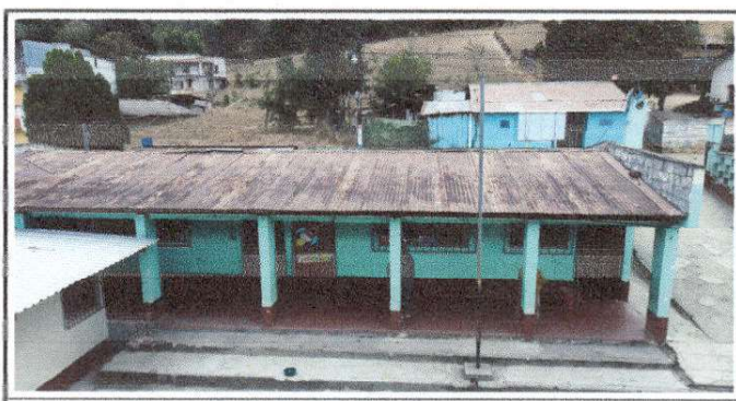
Foto 6: Sustitución de cubierta de laminas y estructura portante en modulo de aulas
