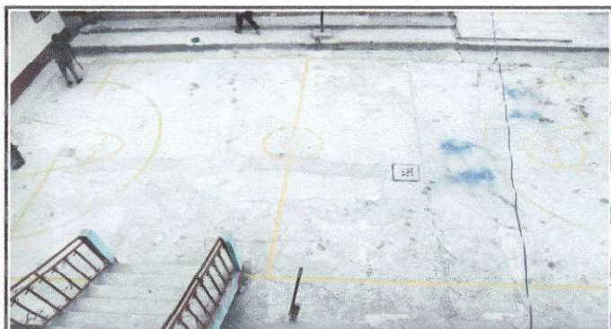
Foto 3: Sustitución de pavimento agrietado, por pavimento de concreto
