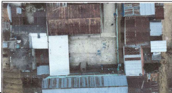
Foto 1: Sustitución de pavimento agrietado, por pavimento de concreto
