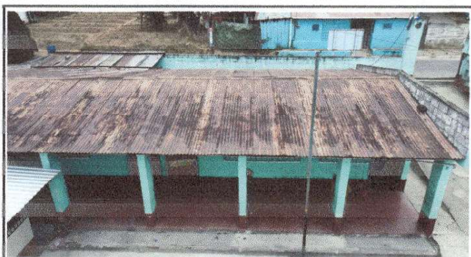
Foto 4: Sustitución de cubierta de laminas y estructura portante en modulo de aulas
