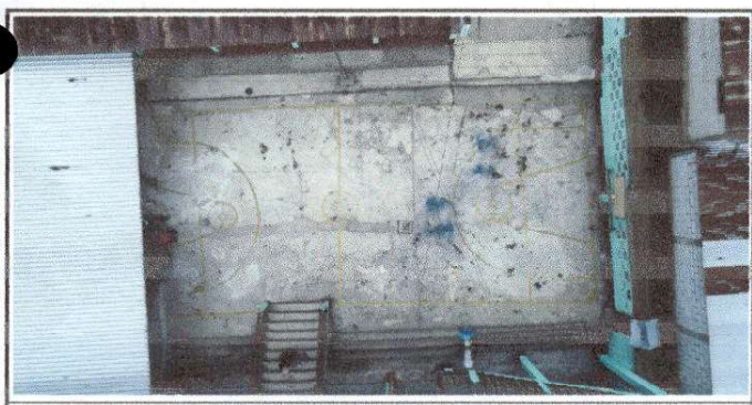
Foto 5: Sustitución de pavimento agrietado, por pavimento de concreto
