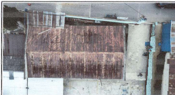
Foto 2: Sustitución de cubierta de laminas y estructura portante en modulo de aulas
