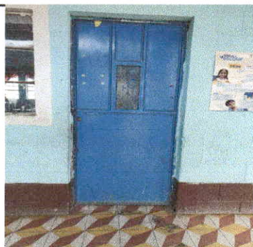
Foto 3: Mantenimiento a estructura (Lijado, corte, cepillado y aplicación de pintura) a 5 aulas del modulo 2
