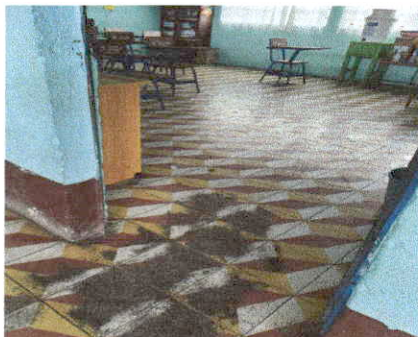
Foto 1: Sustitución de piso del aula No. 6 del modulo 2
