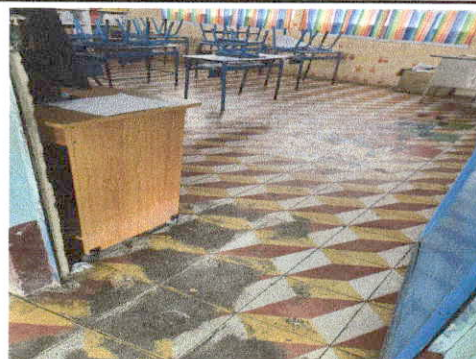
Foto 2: Sustitución de piso del aula No. 8 del modulo 2
