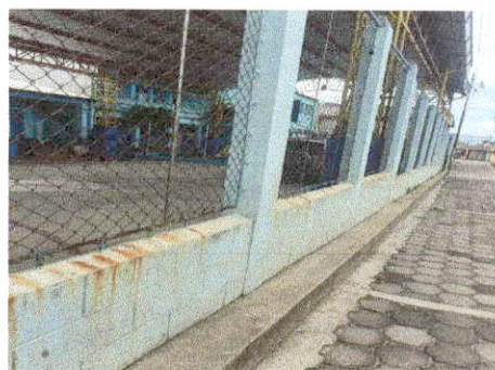
Foto 4: Mantenimiento de pintura en interior y exterior.
