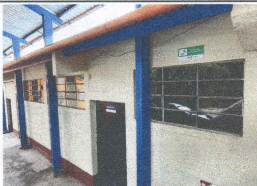
Foto 3: Instalación de rejas de balcon en las ventanas
