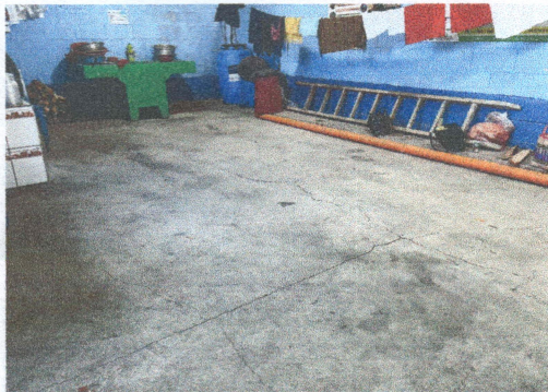
Foto 1: Construcción de plancha de leña, mesa de cocina con pila, sustitución de piso, instalacion de ventana y pintada
