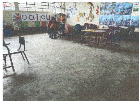
Foto 2: Sustitución de piso cemento a pisos antideslizante
