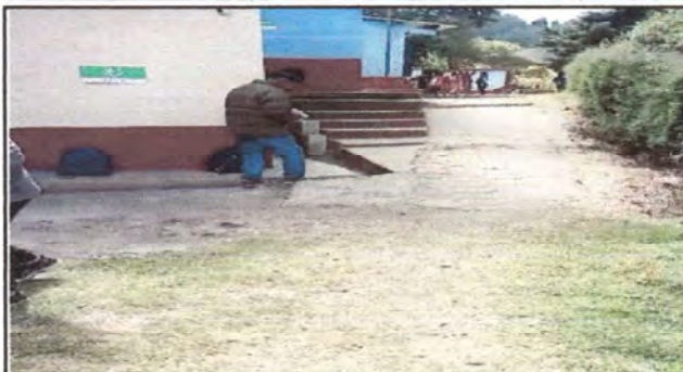
Foto 8: Suministro y fundición de piso de concreto en patio, (módulo de mejoramiento de patio).
