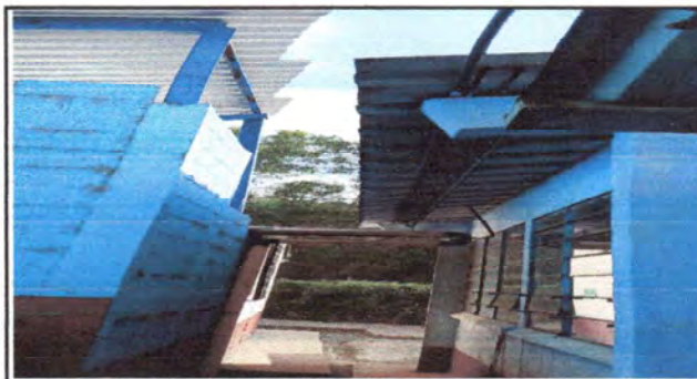
Foto 10: Suministro e instalación de estructura de metal y lámina troquelada entechado de pasillo, (Módulo de pasillo).
