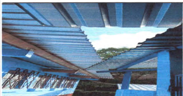
Foto 5: Suministro e instalación de pescantes y canales tipo colonial para el agua pluvial (módulo de caída de agua)
