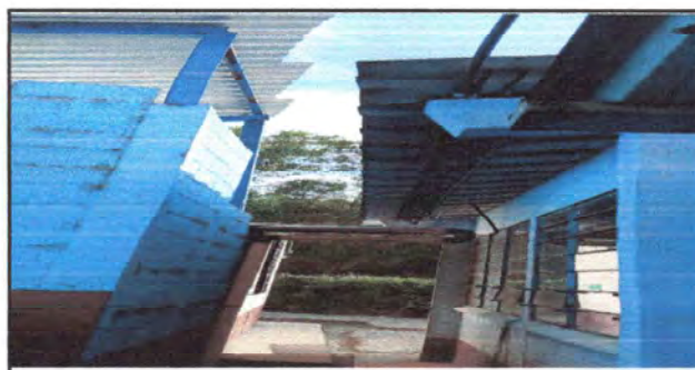
Foto 6: Suministro e instalación de pescantes y canales para agua pluvial (módulo de caída de agua)
