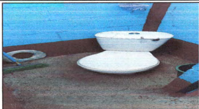
Foto 1, Suministro e instalación de inodoro, (módulo de seervico sanitario)
