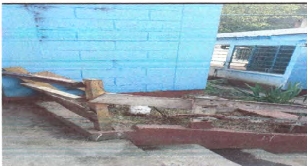
Foto 9: Suministro e instalación de estructura y lámina troquelada entechado de pasillo (Módulo de pasillo).
