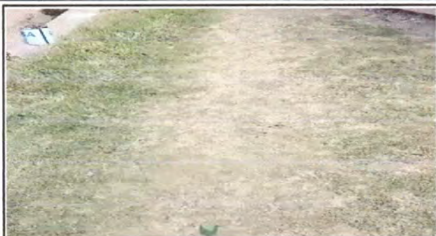
Foto 7: Suministro y fundición de piso de concreto en patio, (módulo de mejoramiento de patio).
