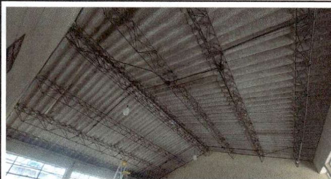
Foto 2: b. Mantenimiento a la estructura de techo mediante la aplicación de pintura anticorrosiva en 4 aulas y 1 bodega
