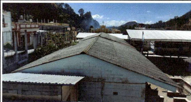
Foto1: a. Sustitución láminas de duralita por láminas troquelada de calibre 26 en 4 aulas y 1 bodega.
