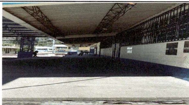
Foto 3: Sustitución de canal de PVC y reubicación de canal de bajada de agua en 2 aulas
