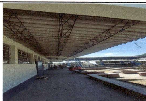
Foto 4: Colocación de canal y bajada de agua para 2 aulas y 1 bodega.
