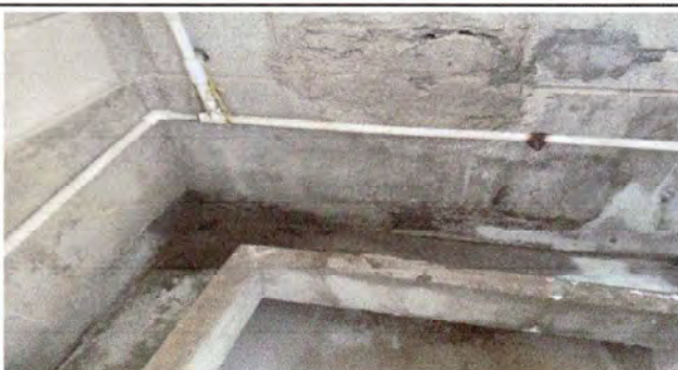
Foto 3: Instalacin de azulejo en mijitorio del baio.
