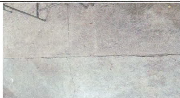
Foto 1: Sustrucción de piso en dos aulas, direccin y cocina
