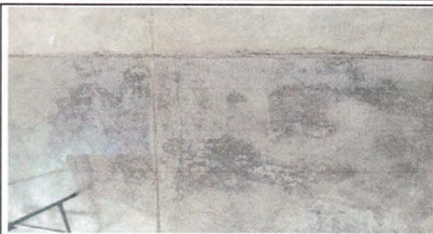
Foto 2: Sustrucción de piso e dos aulas
