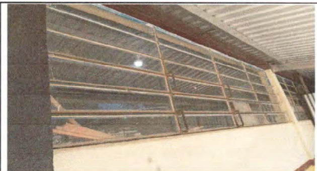
Foto 4: Sustrucción de ventanas en dos aulas, direccin y cocina.
