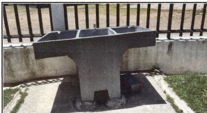
Foto 3: Mantenimiento de pilas existentes
