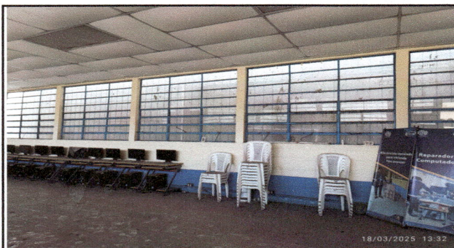
EN ESTA FOTO SE MUESTRA EL CAMBIO NECESARIO DE VIDRIOS
