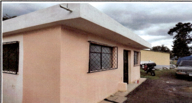
EN ESTA FOTO SE MUESTRA EL CAMBIO NECESARIO DE LA PINTURA EXTERNA DE LA COCINA
