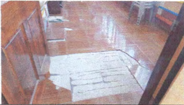
reparación de piso ceramico
