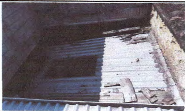
sustitucion de lamina
