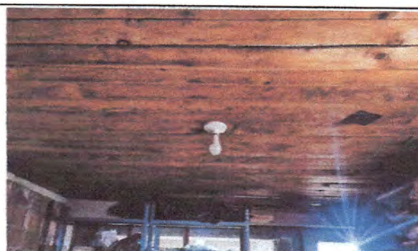
intalacionde cielo falso
