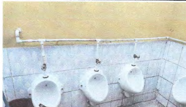
sustitucion de mingitorios y llaves
