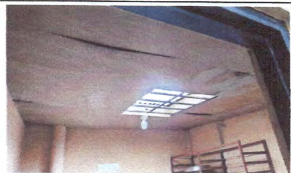
intalacion de cielo falso
