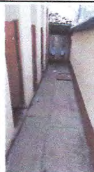
instalacion de piso antideslizante
