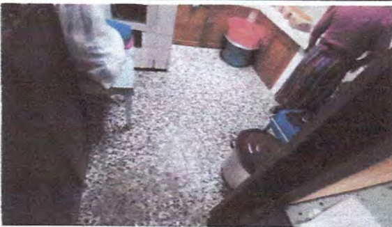
instalacion de piso antideslizante
