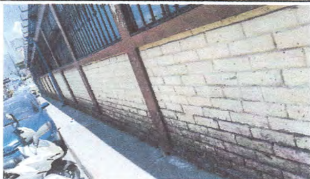
pintura en muro exterior
