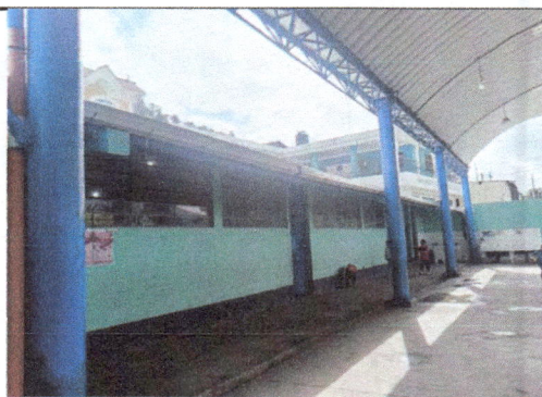
Foto 3: Canal y bajadas de agua
